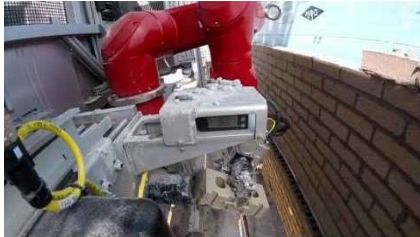
Construction Robotics – canteiro de obras no Missouri (EUA)
