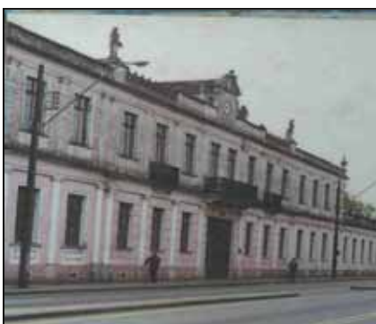
Figura 33: Prédio do Ministério Público antes da restauração Fonte: Acervo da Secretaria Municipal de Comunicação Social
