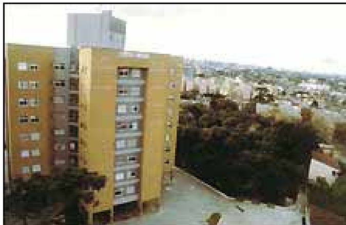
Figura 17: Prédio residencial com parâmetros especiais de ocupação em face da preservação do bosque.
