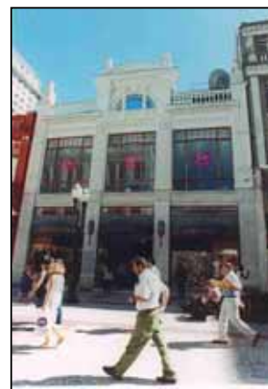
Figura 68: Casa Louvre em bom estado de conservação após a utilização da TPC. Fonte: Acervo da Secretaria
