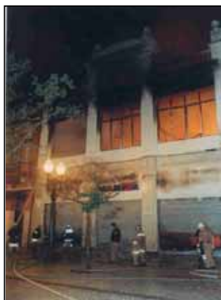
Figura 67: Casa Louvre em precário estado de conservação Fonte: Acervo da Secretaria Municipal de Comunicação Social.
