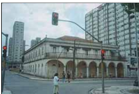
Figura 69: Casa Emílio Romani em precário estado de conservação. Fonte: Acervo Secretaria Municipal de Comunicação Social
