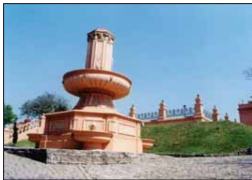
Figura 32: Reservatório Alto São Francisco após a restauração Fonte: Acervo da Secretaria de Comunicação Social
