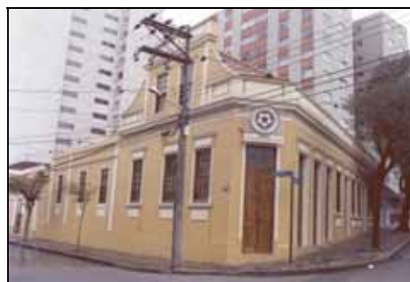
Figura 65: Edificação restaurada antes mesmo de efetuar a 1ª transferência de Potencial Construtivo Fonte: Secretaria Municipal de Comunicação Social.
