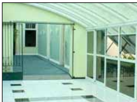
Figura 48: Interior da passarela metálica que interliga a Casa Glaser com o empresarial
