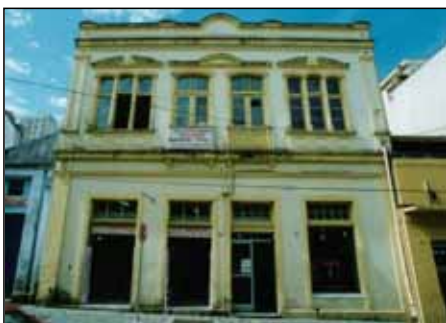
Figura 71: Imóvel antes da restauração. Acervo: Acervo da Secretaria Municipal do Urbanismo
