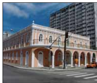
Figura 70: Casa Emílio Romani após a TPC, apresentando bom estado de conservação. Fonte: Acervo Secretaria Municipal de Comunicação Social
