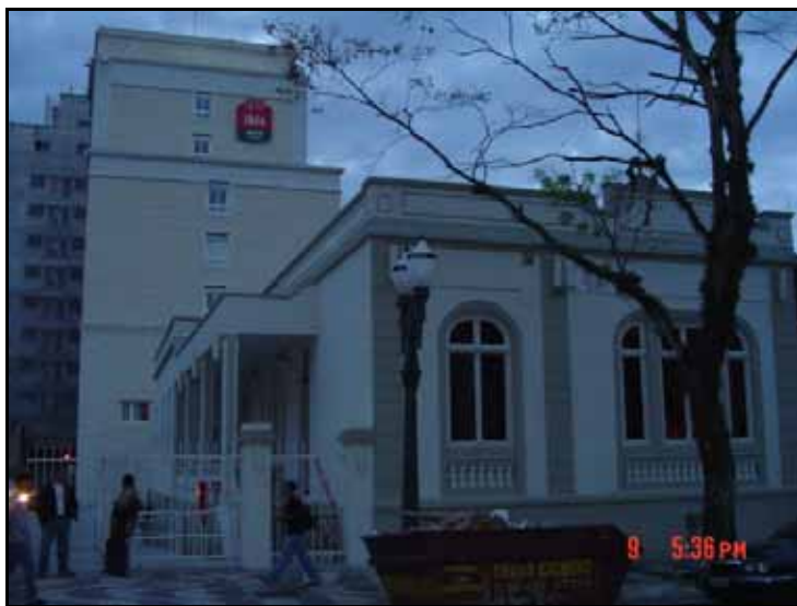
Figura 15: Hotel IBIS - construção do edifício que abriga os apartamentos do hotel atrás da UIP, utilizando o potencial construtivo no mesmo lote. Foto: Ana Paula Bitencourt Data: Junho/ 2004
