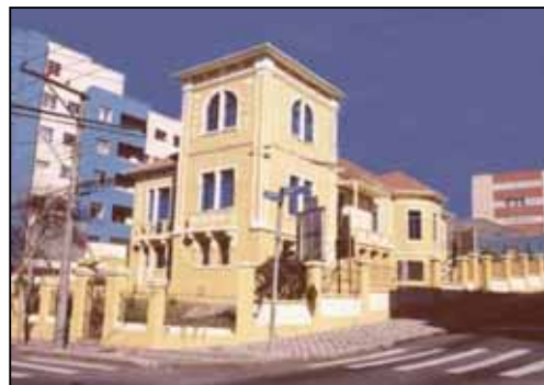
Figura 36: UPE após a restauração
