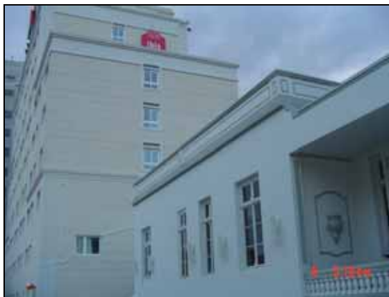
Figura 49: Hotel IBIS, com a UIP e edifício construído aos fundos.
