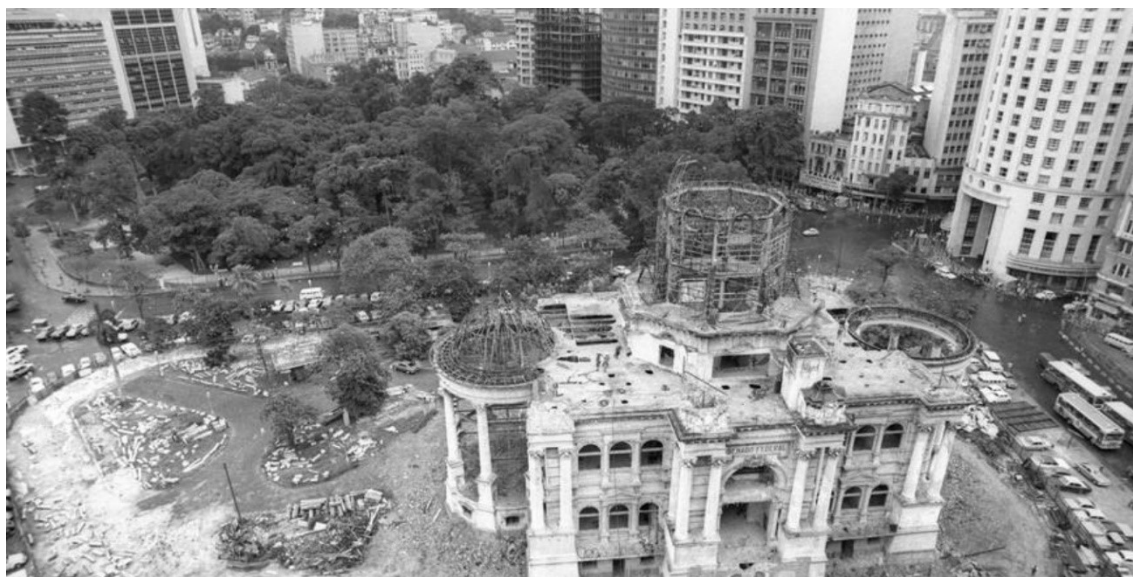
15. Palácio Monroe sendo demolido no Rio de Janeiro. Foto: Alcyr Cavalcante, 1976.
