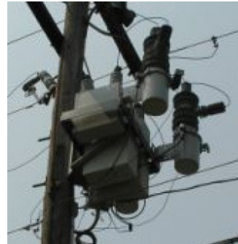
Banco de capacitores com controle automático do chaveamento
