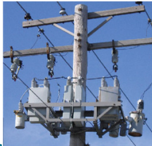
Banco de capacitores para instalação em postes
