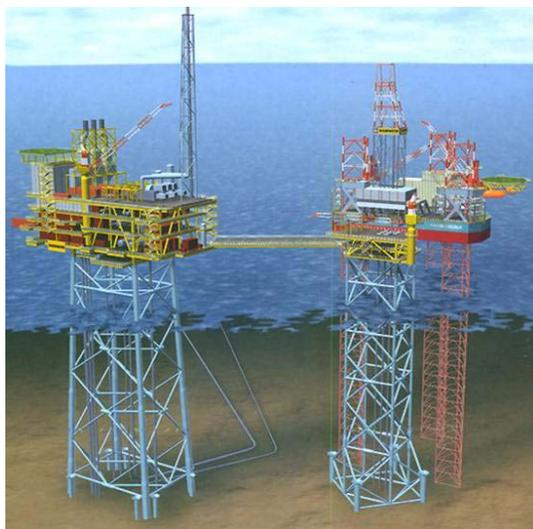
**Figura 1.2** Plataforma do tipo jaqueta (extraído de *Offshore Technology*, 2002)
