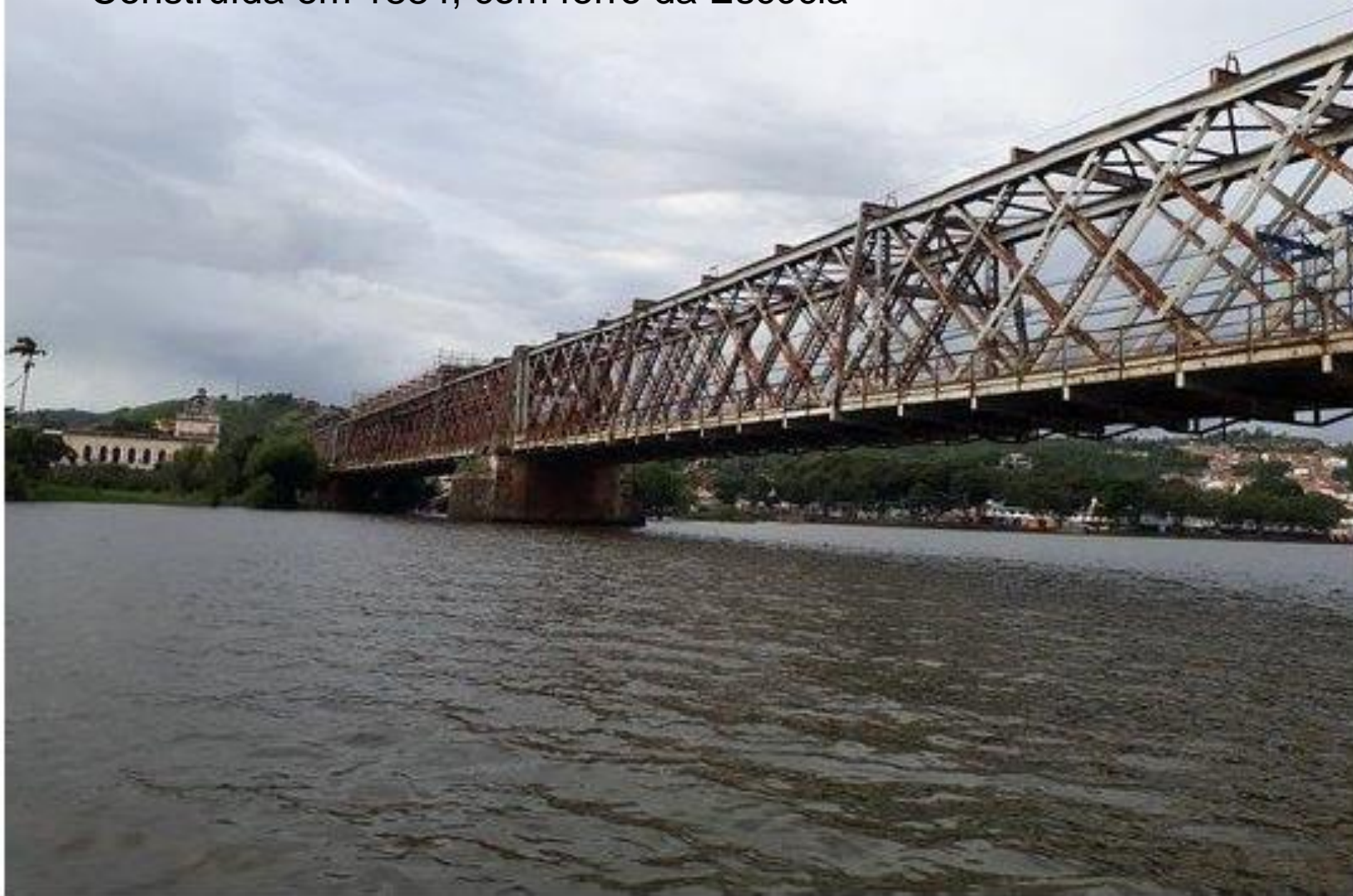
Figura 6: Ponte Imperial D. Pedro II, sobre o Rio Paraguaçu, que divide as cidades Cachoeira e São Félix. Fonte: A, C., 2018
