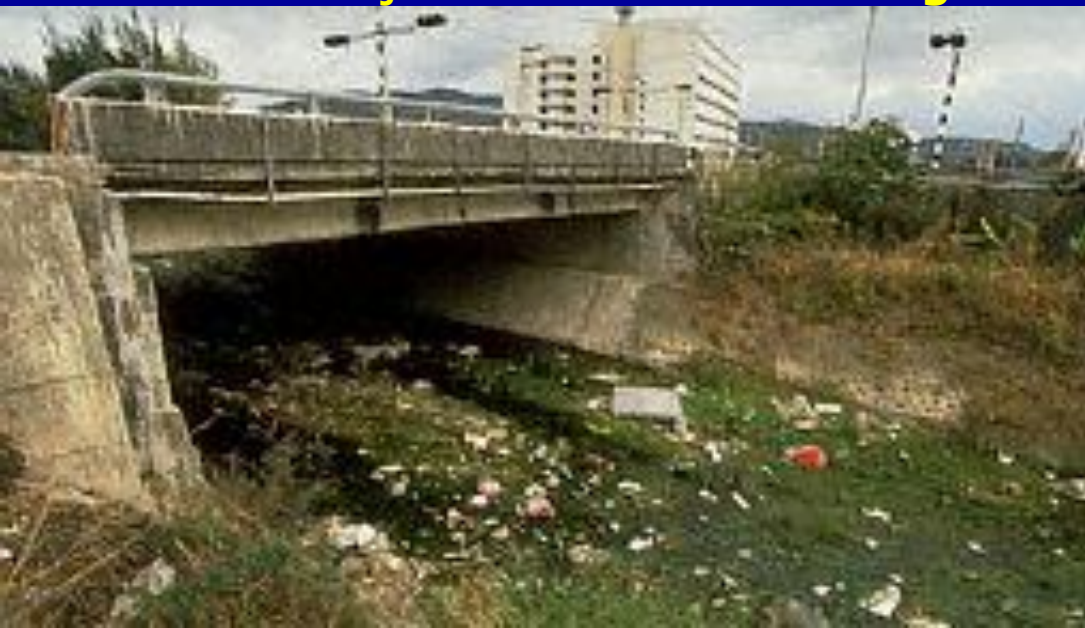
Obstrução de canais de drenagem
