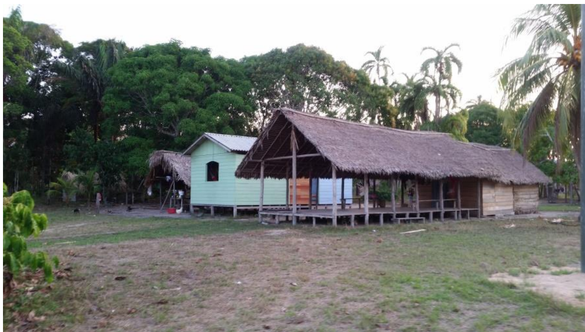
Figura 5 – Construção de uma casa na comunidade Boa Fé.
