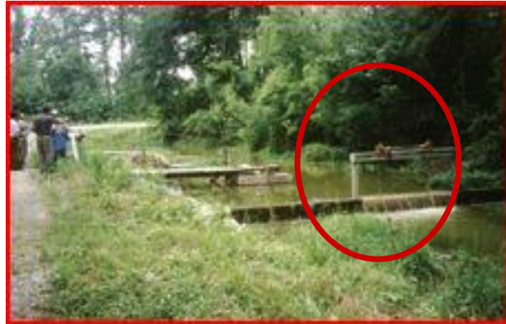
Dreno coletor da água de drenagem dos viveiros
