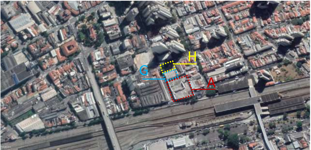
Figura 1 – Foto Aérea dos Terrenos A, G e H.
