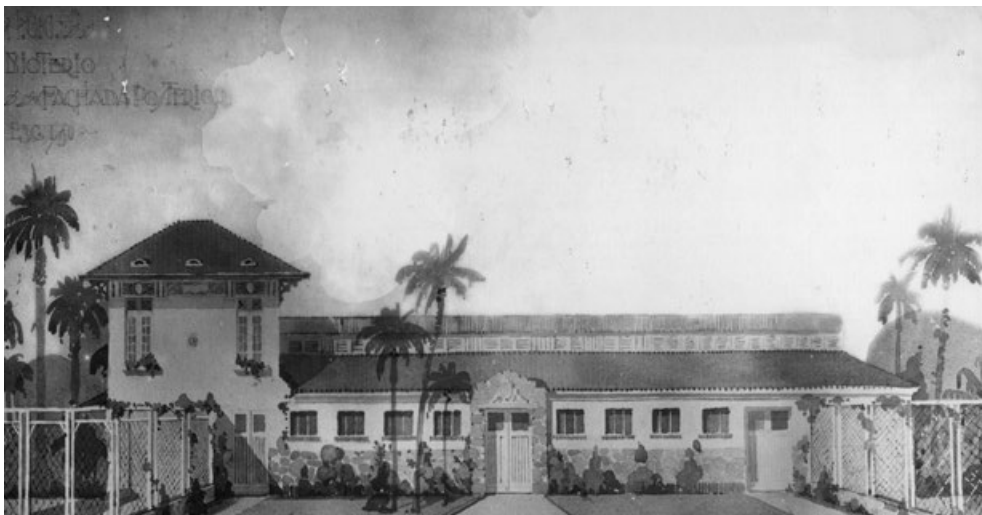
Figura 11: Hospital Gaffrée e Guinle – Biotério, fachada posterior. Fonte: Acervo família Paula Machado.
