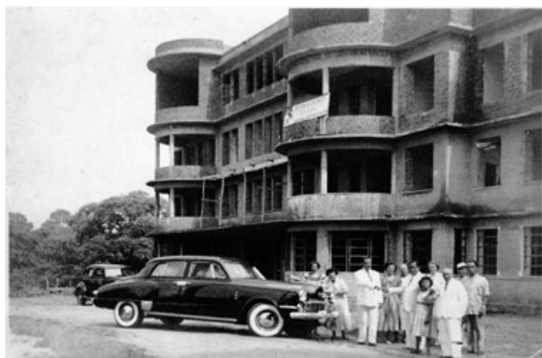
Figura 1: Hospital Aristides Maltez, em Salvador, durante sua construção. Fonte: Acervo Hospital Aristides Maltez.
