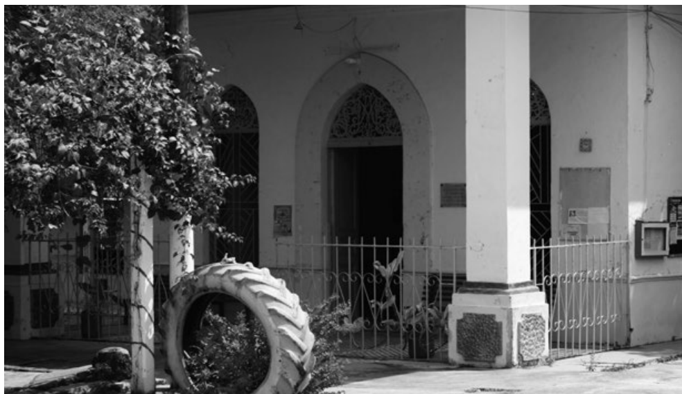
Figura 11: Detalle acceso albergue San Vicente. Fotografía Carlos Eduardo Nieto, 2012. Fuente: IGAC Bogotá.
