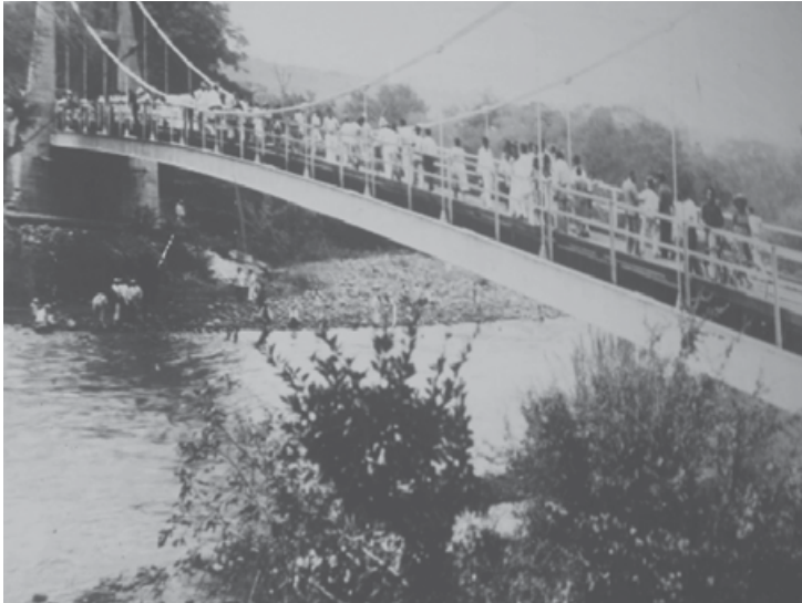
Figura 1: Puente de los Suspiros, camino de acceso a Agua de Dios. Tomado de Sanatorio de Agua de Dios
