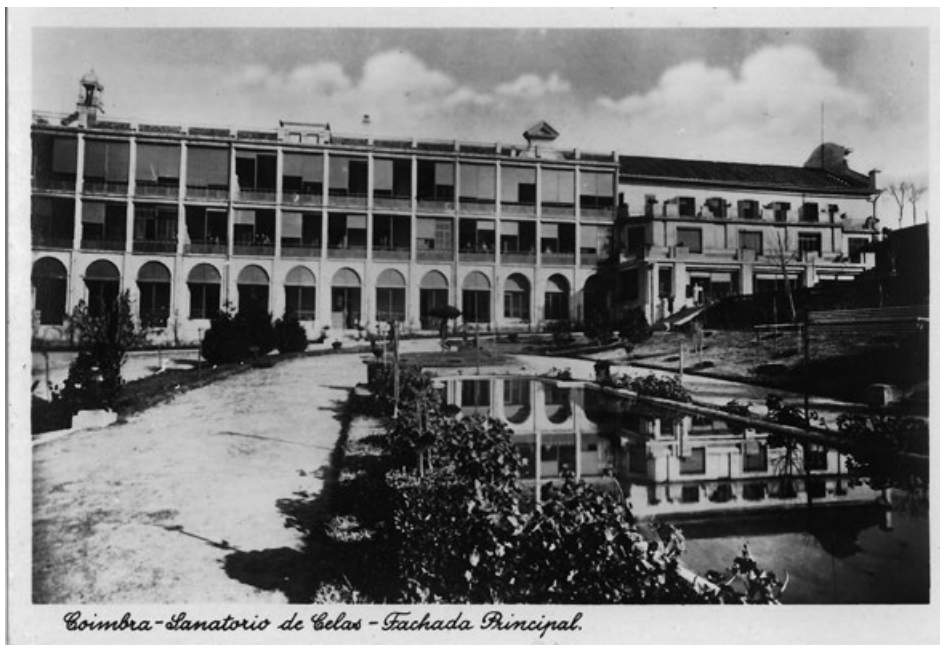
Figura 3: Sanatório de Celas. Fachada Principal. Fonte: Centro de Documentação Bissaya Barreto.
