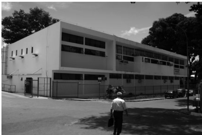
Figura 10: Parque Sanatorial Santa Terezinha: fachada norte do Pavilhão de Triagem, no seu estado atual. Fonte: foto realizada pelo autor, 11 fev 2011.
