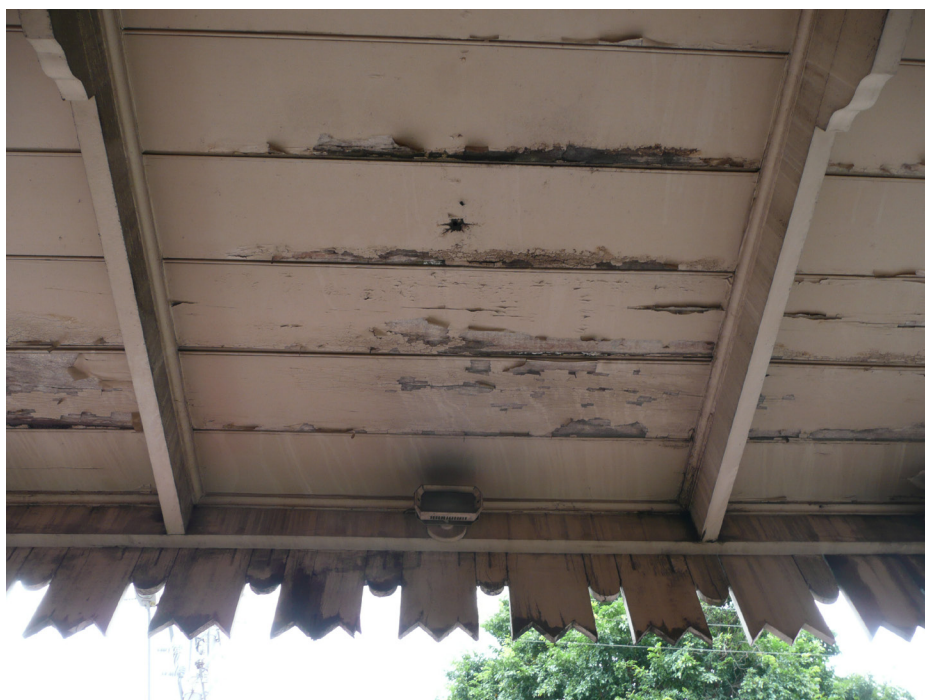
Estrutura da marquise do acesso secundário
