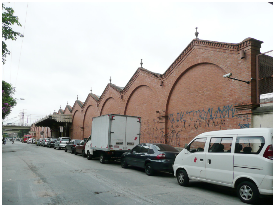
1- Vista geral fachada
