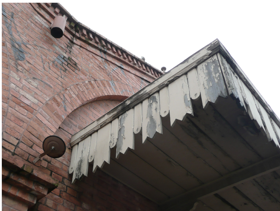
Elevação lateral da marquise do acesso secundário
