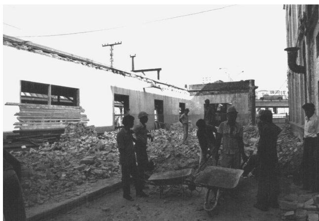
Ala da antiga Estação do Brás ao lado da Estação Roosevelt em demolição em 1978 FONTE: Processo de tombamento - CONDEPHAAT
