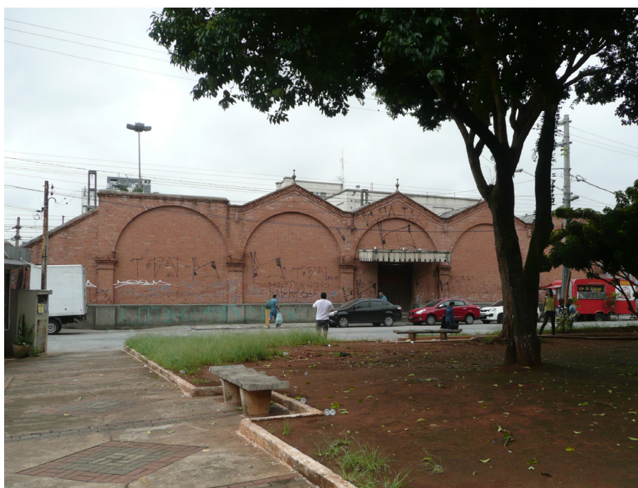
2- Acesso secundário da estação
