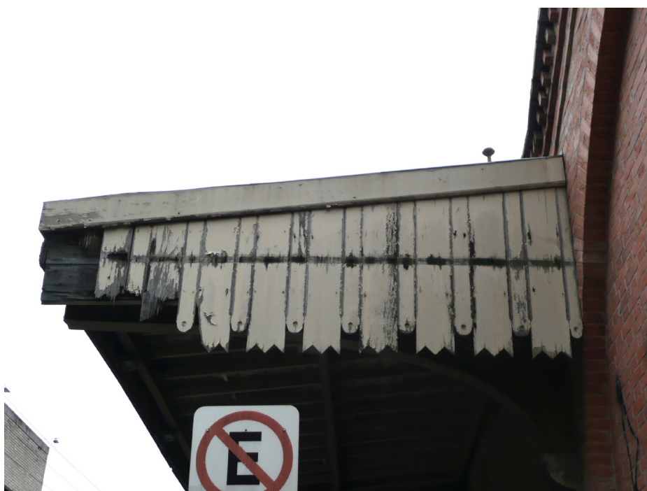
Lambrequins da elevação lateral da marquise do acesso principal
