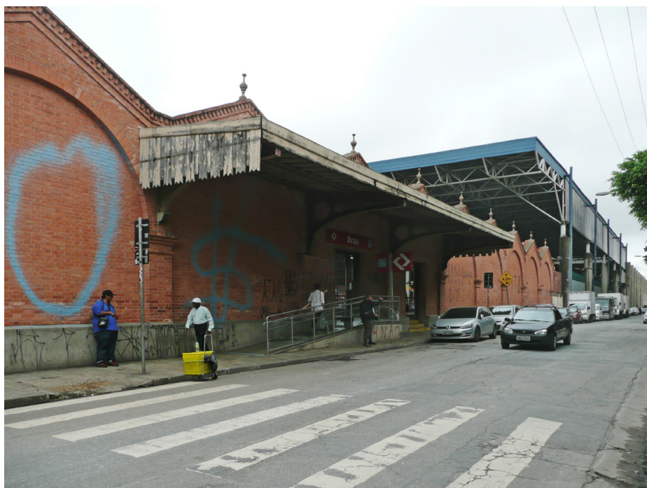
1- Acesso principal da estação
