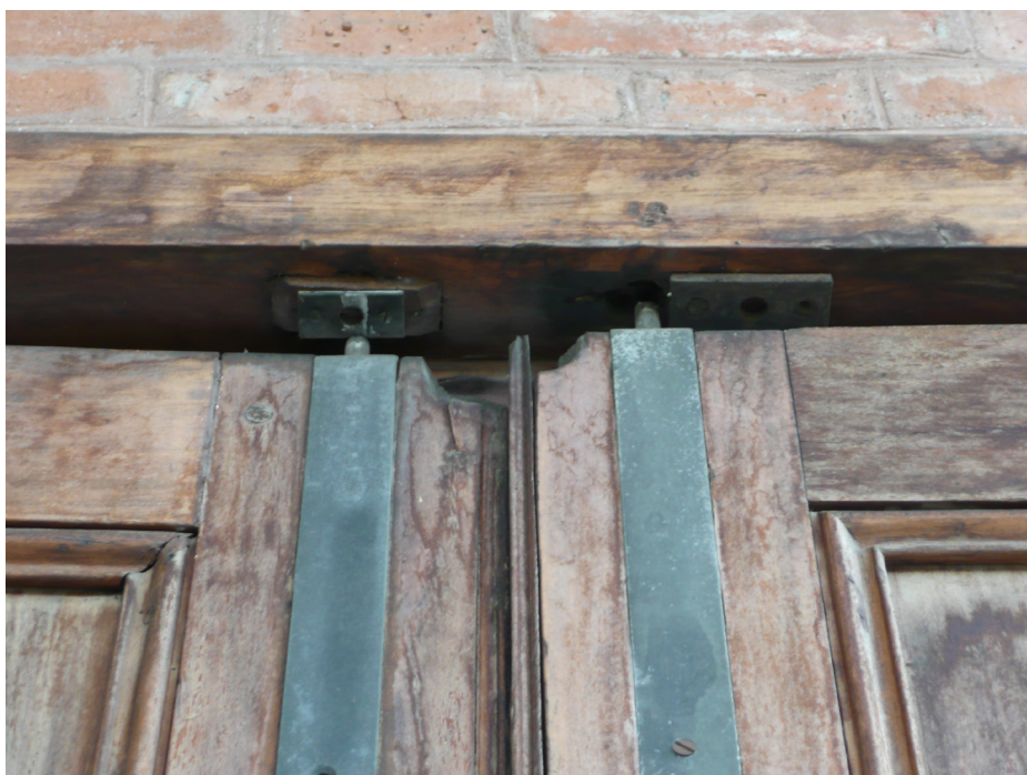
Detalhe dos trincos superiores
