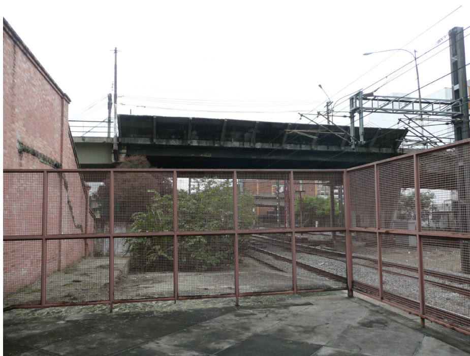
2- Vista do viaduto Maestro Alberto Marino a partir da plataforma
