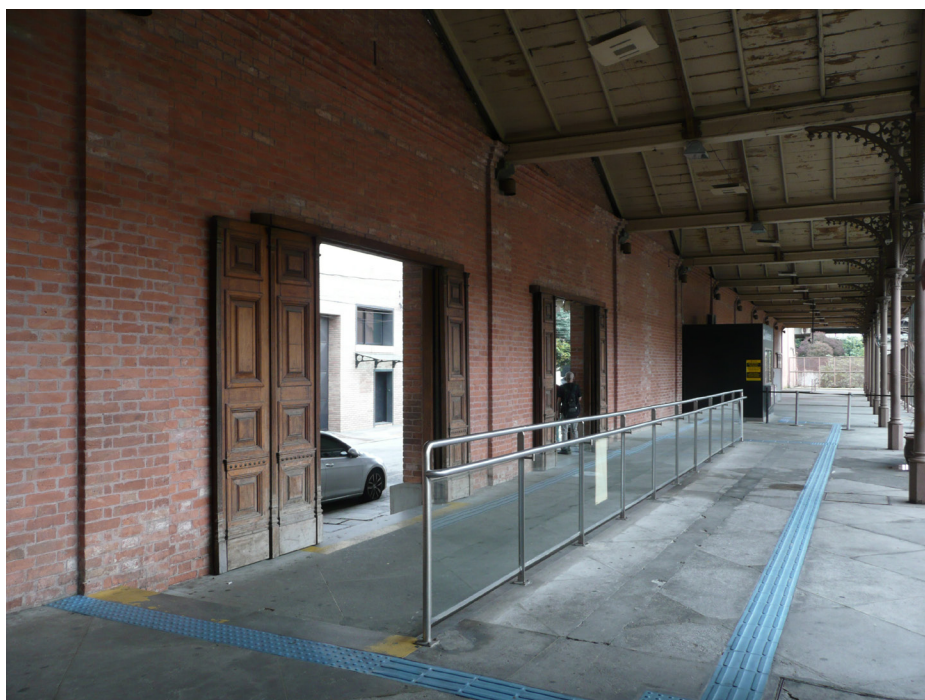
1- Plataforma junto ao acesso principal
