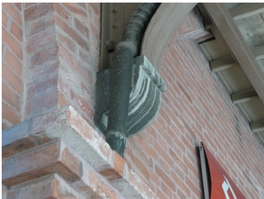
Descida de água pluvial
