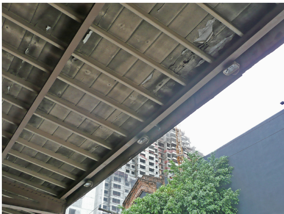
Estrutura da marquise
