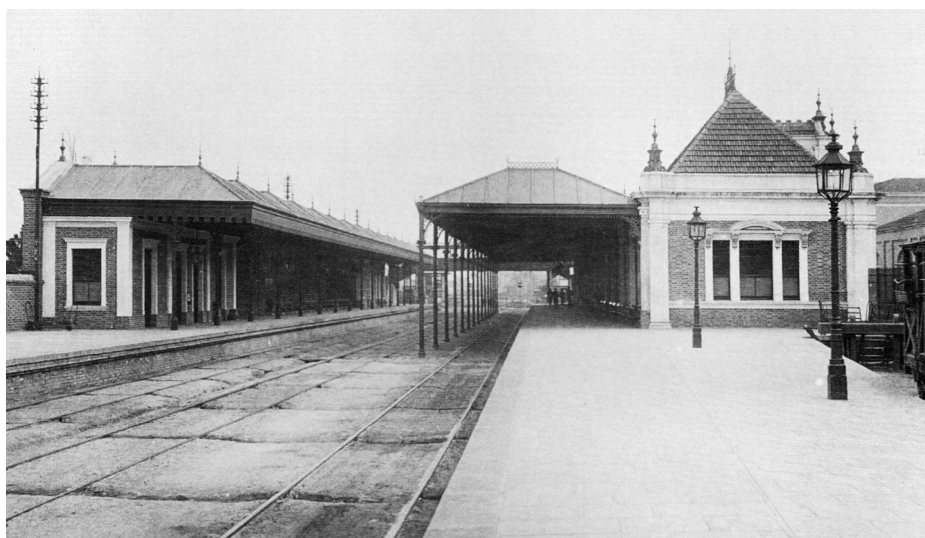
Antiga Estação Brás, inaugurada em 1897 FONTE: LAVANDER, p. 122
