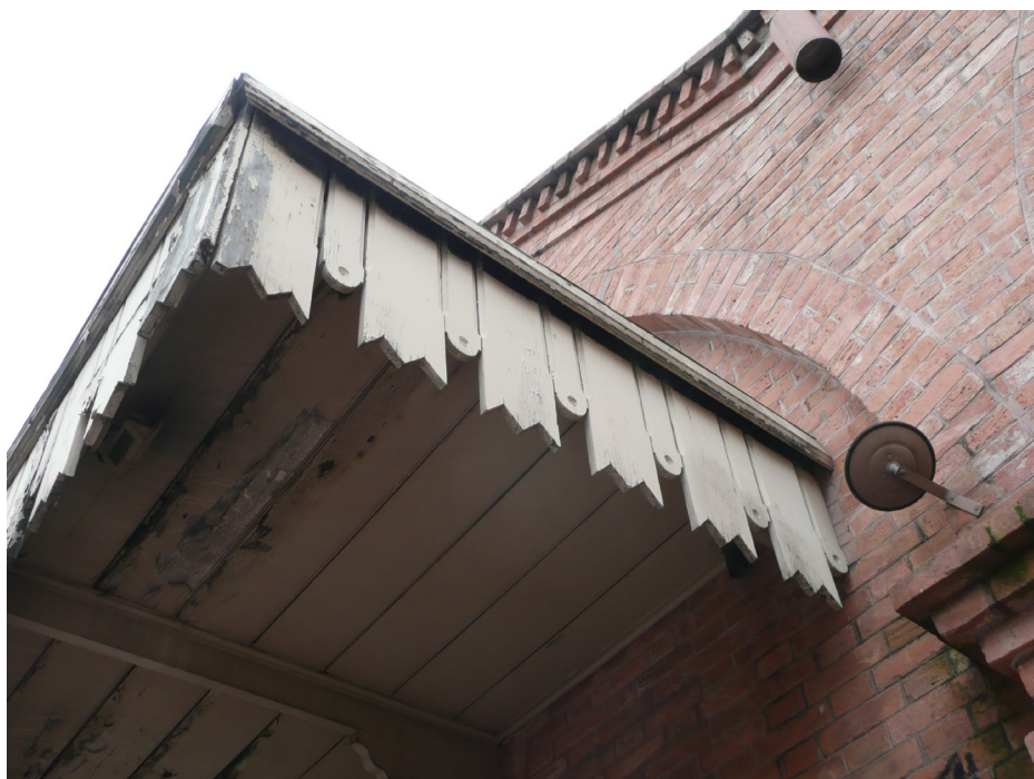
Elevação lateral da marquise do acesso secundário
