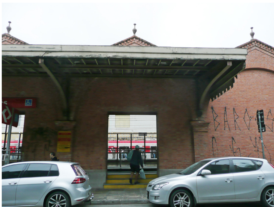
Vista da marquise no acesso principal por escada
