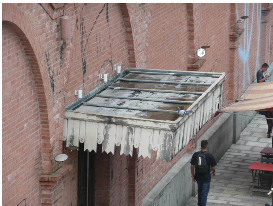
Vista da marquise do acesso secundário a partir do Viaduto Maestro Alberto Marino
