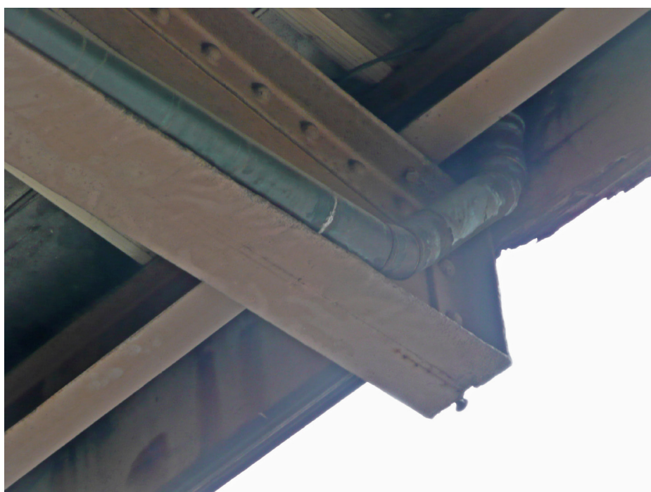
Descida de água pluvial
