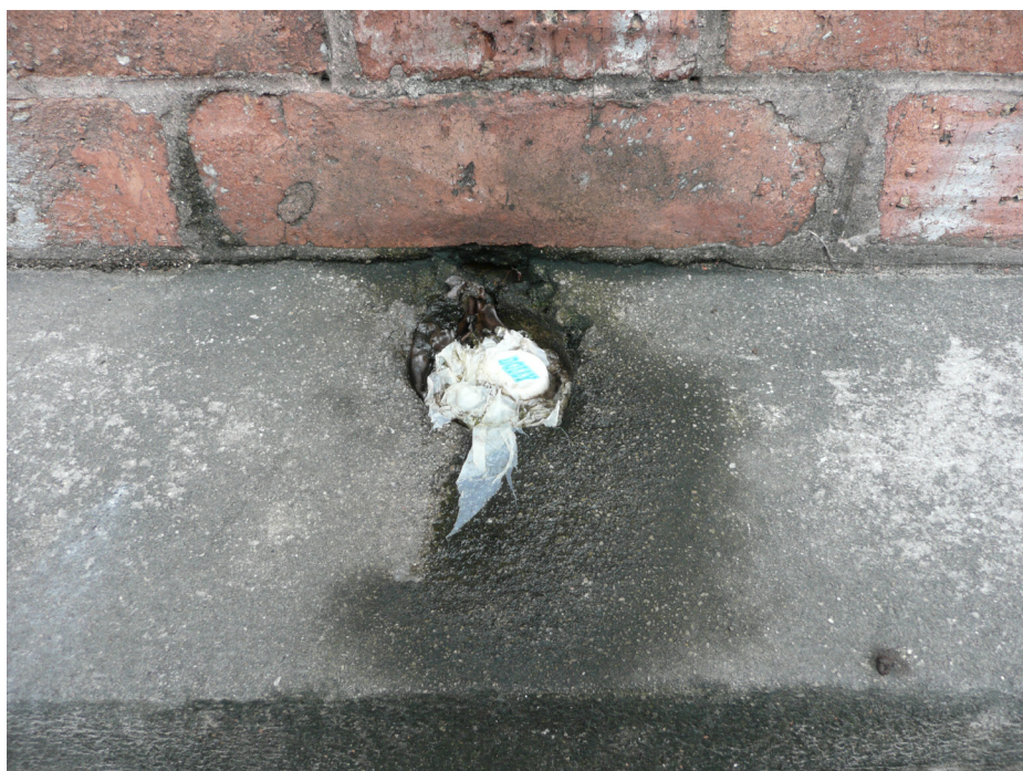
Trecho da descida de água pluvial embutido no embasamento da fachada
