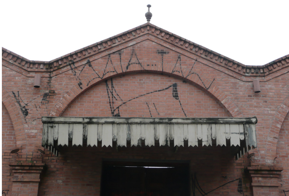
Elevação frontal da marquise do acesso secundário
