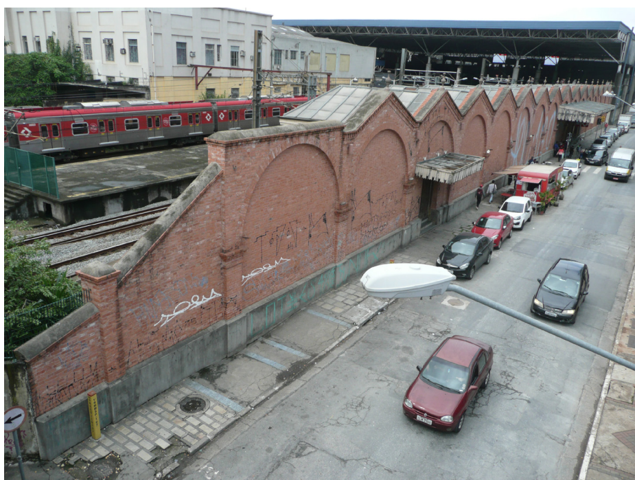
2- Vista da fachada a partir do Viaduto Maestro Alberto Marino
