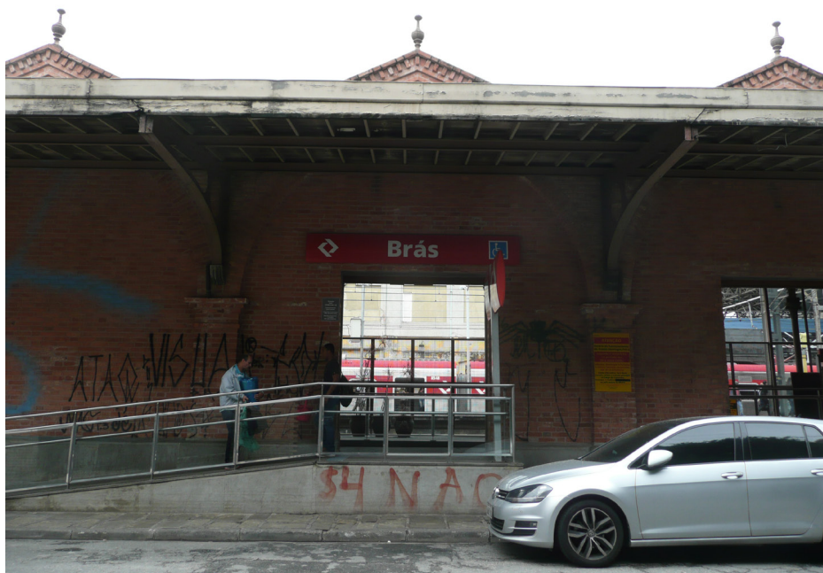
Vista da marquise no acesso principal por rampa de acessibilidade
