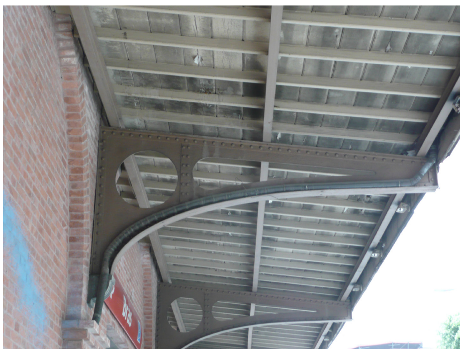
Estrutura da marquise e descida de água pluvial
