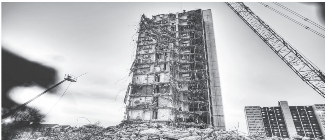
Figura 2: Demolição do Conjunto Cabrini Green, Chicago
