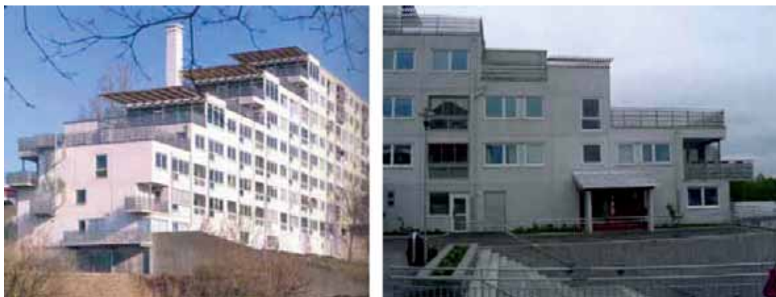
233. 234. Conjunto residencial Gardsten, Gotenburgo, Suécia.
