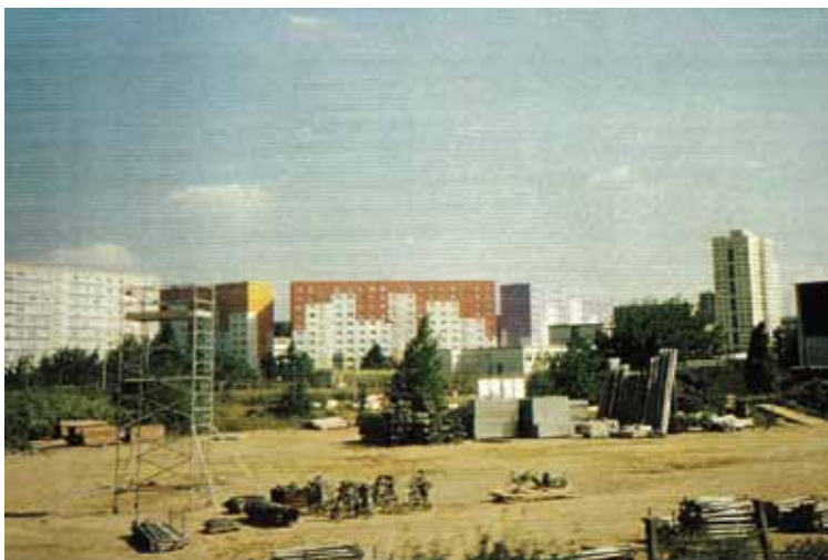
215. Conjunto residencial em obras, Berlim, 1998.
