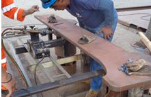
Preparação das peças dos skids (11 x) Transversal (painéis ( skids ) e nervuras)
