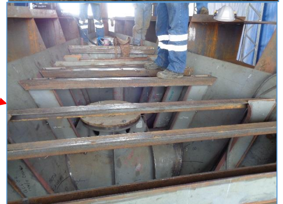
Terminación de Armado y Soldadura Interna Sección 115 A
