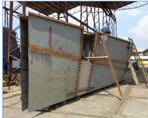
Terminación de soldadura Sección 115B
