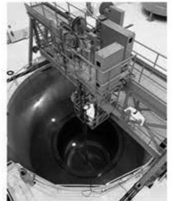
FIGURA 17.26 O núcleo de um reator que usa água leve (LWR) de uma usina de energia nuclear opera imerso em água.
