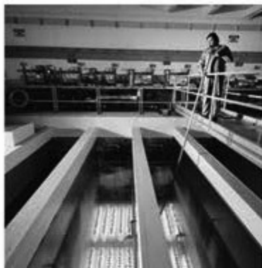
FIGURA 17.29 Recipientes com altos níveis de resíduos, inclusive céσιο-137 e estrôncio-90, brilham sob uma camada protetora de água. Se os recipientes não estivessem protegidos, a radiação que eles emitiriam seria grande o bastante para provocar a morte em cerca de 4 s.
