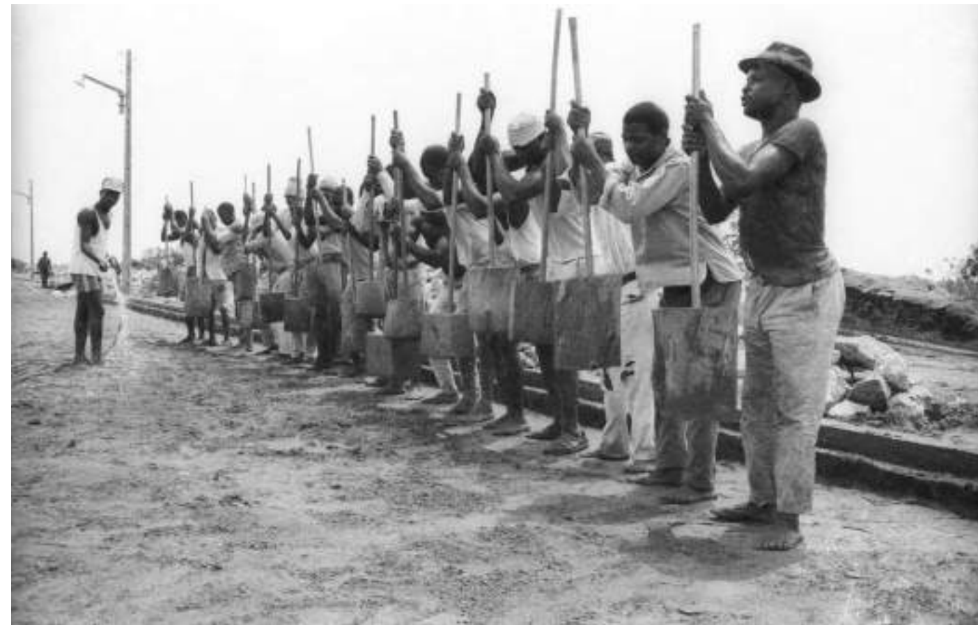
35. Trabalhadores na construção de estrada, anos 1960. Fonte: CDFP.
