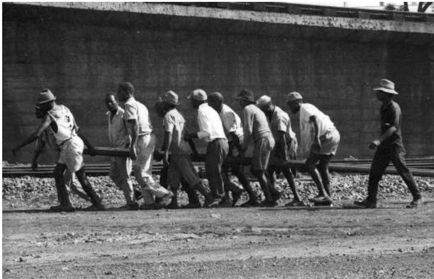
36. Construção de linha férrea, anos 1960. Fonte: CDFE.
