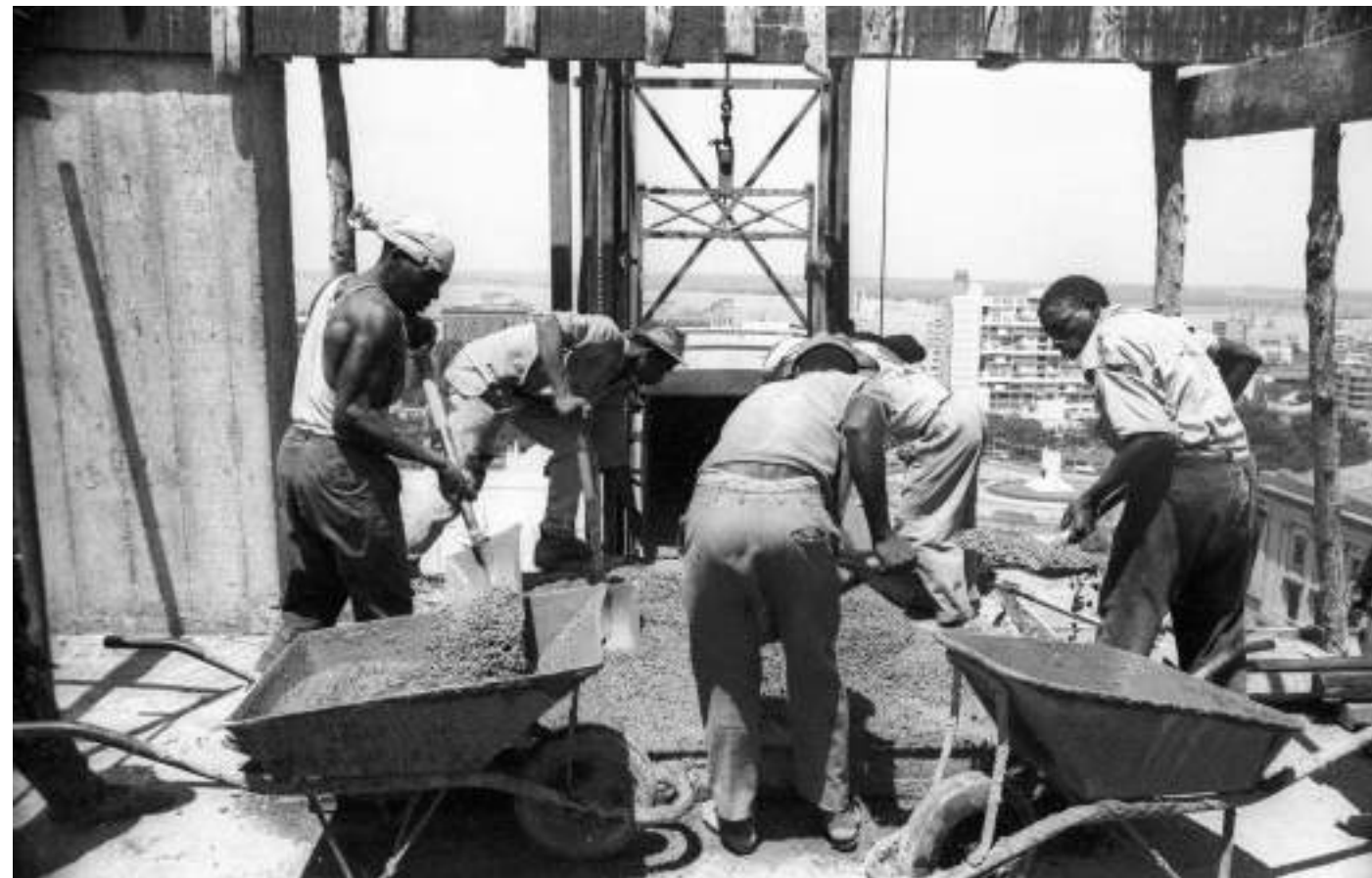
37. Trabalhadores preparando o cimento, anos 1960. Fonte: CDFE.
