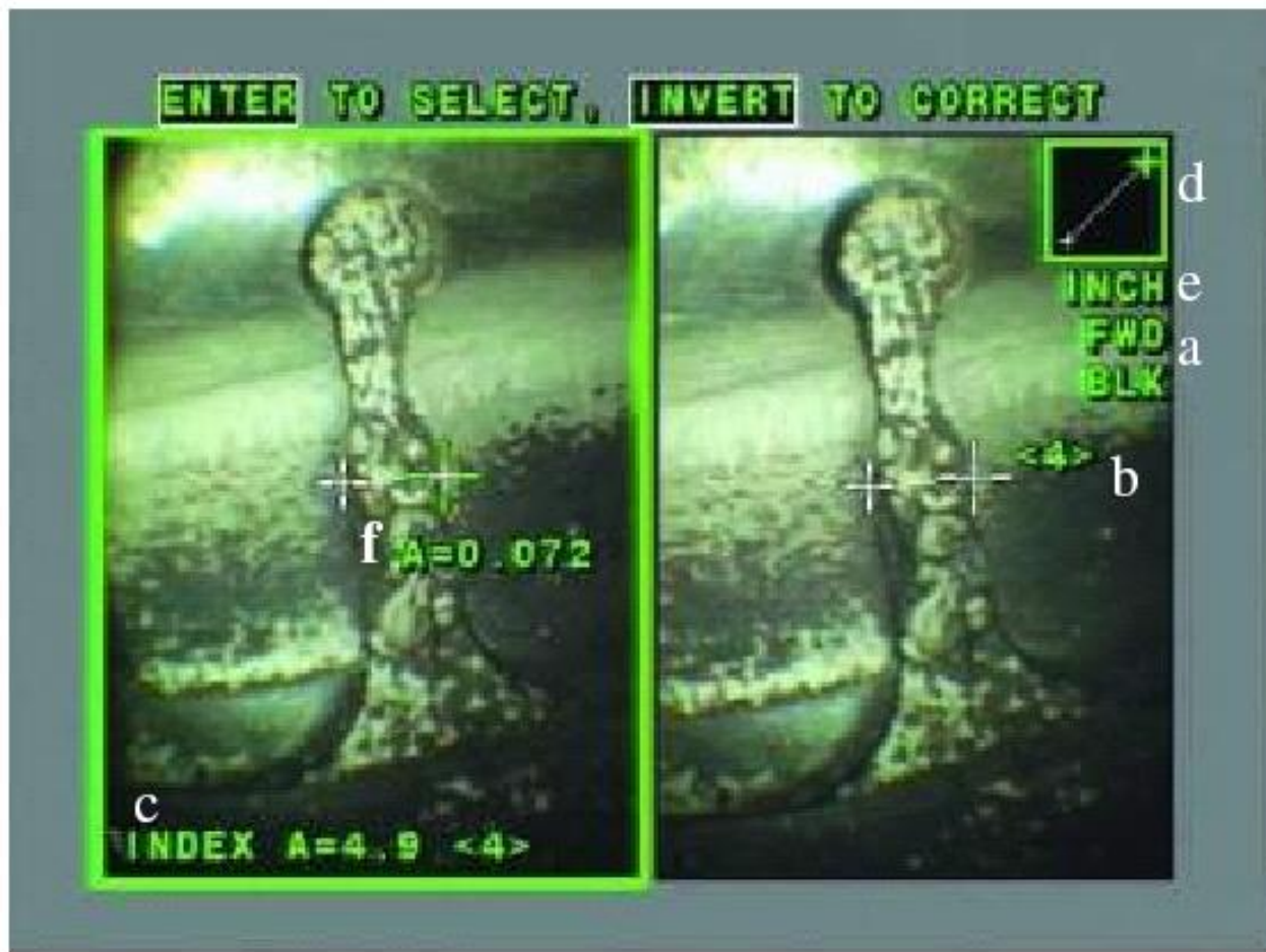
Figura 14 – Exemplo de medida de corrosão , utilizando técnica estéreo , na parte interna de equipamento petrolífero. Na figura vemos que o software mostra a ponta que está sendo utilizada(a) , o índice de acuracidade(b) , o índice de aumento(c) , o croquis da medida(d) que está sendo realizada , a unidade de medida(e) e as dimensões medidas(f).
