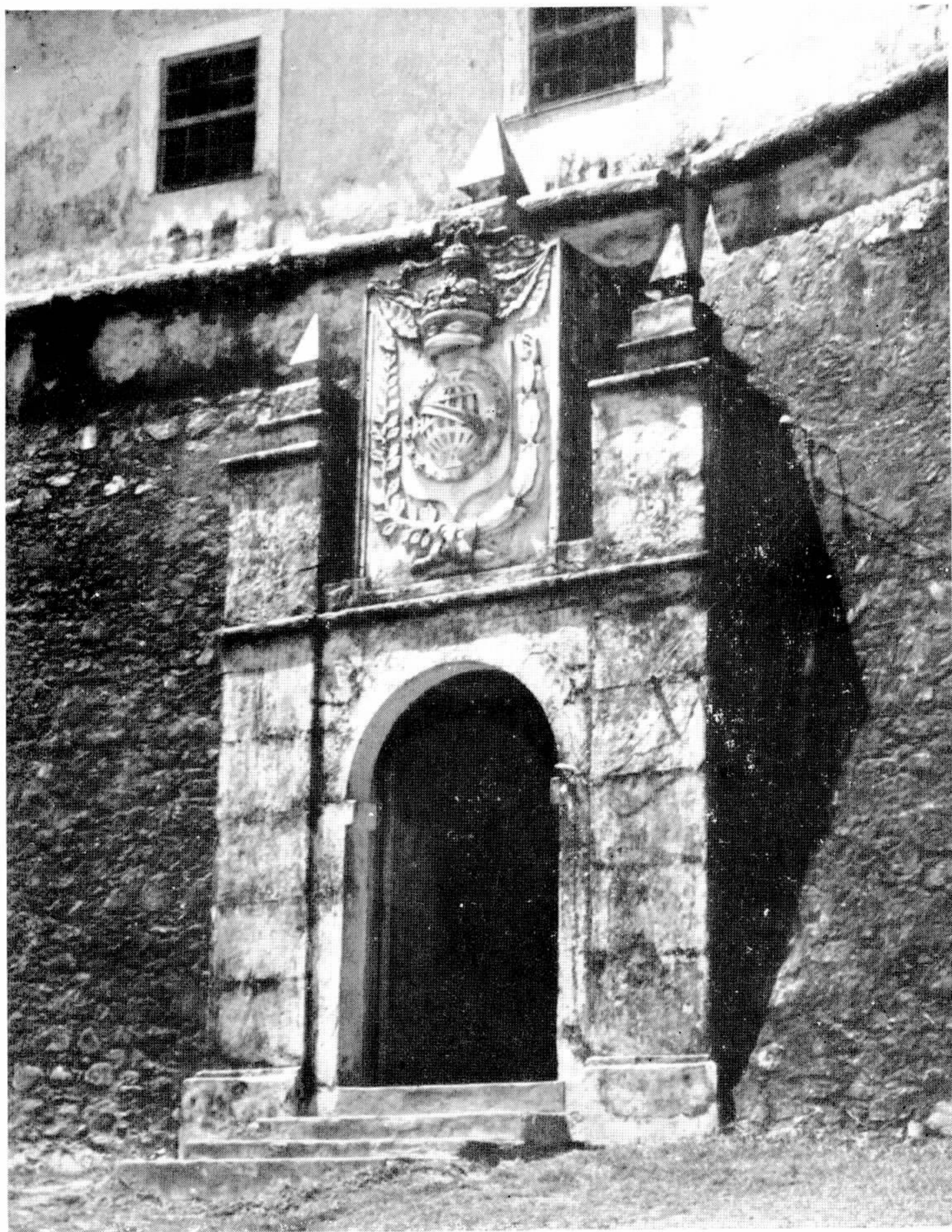
Fig. 6 — Entrada do Forte de Santo Antônio da Barra. Foto Gautherot.
