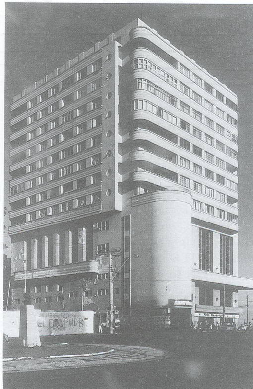
25. Freire & Sodré: edifício Oceania, Salvador, BA, décadas de 1930-1940.
