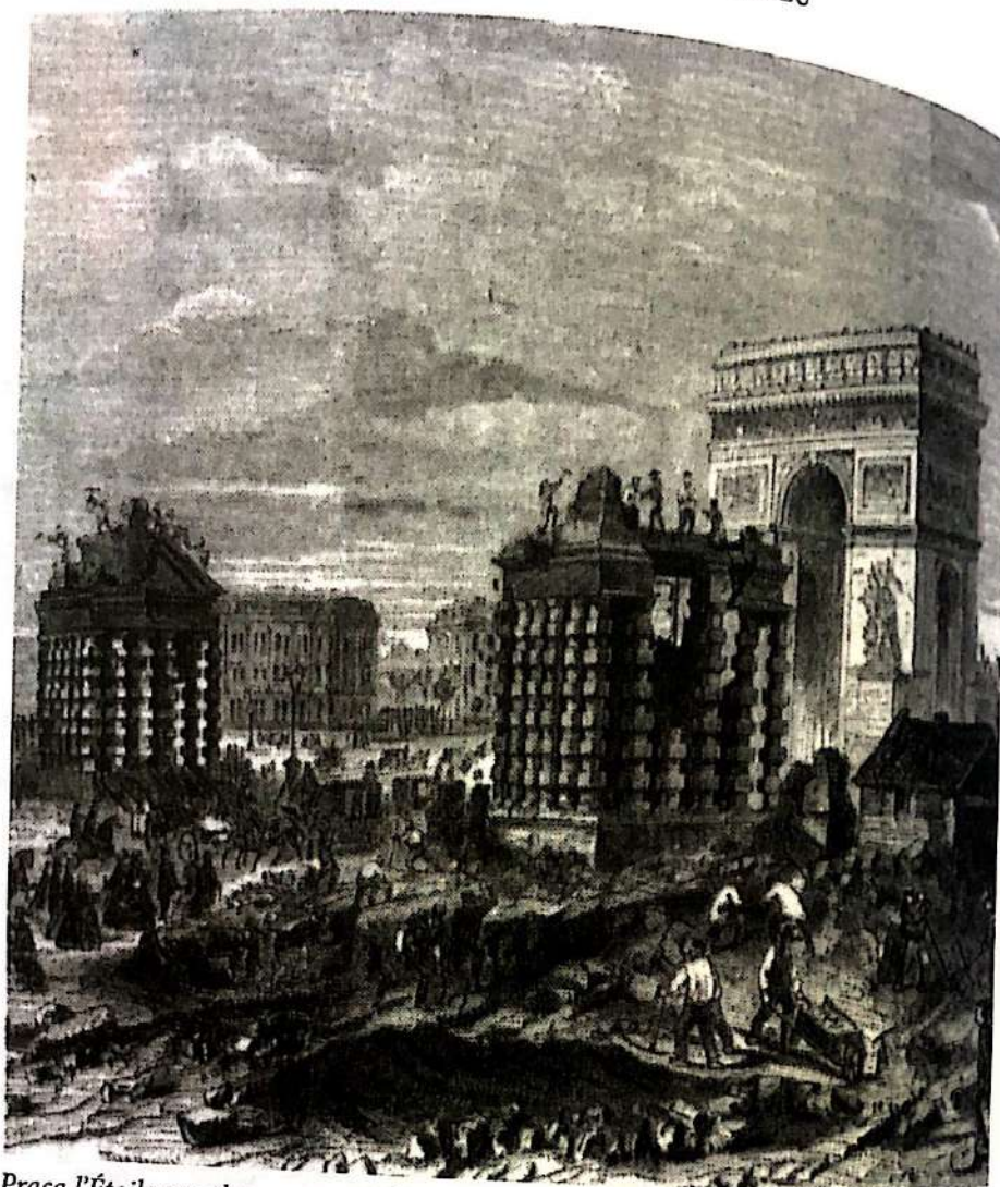
Praça l'Étoile em obras: para realizar uma praça aberta ao tráfego, o barão Haussmann mandou demolir as muralhas de Ledoux.
