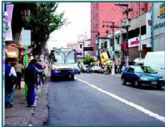
Figura 1 – Faixa exclusiva com segregação física, com pintura viária, no sentido do fluxo de tráfego.
