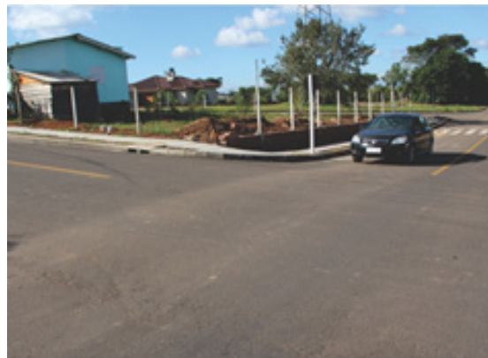
Contribuição de Melhoria na Rua Cel. Brito – Venâncio Aires-RS (DEPOIS da obra)
