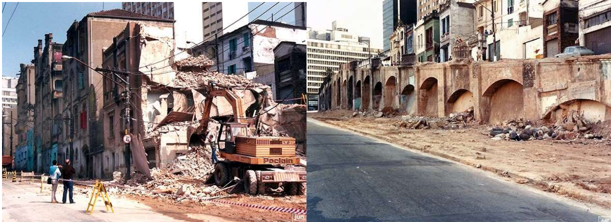
Figuras 6a e 6b - A demolição dos casarões. À esquerda, escavadeira derrubando edificações na Rua da Assembleia. À direita, os arcos sendo revelados em meio ao processo de destruição. Fotos: Ronald Kyrmse, 1987.
