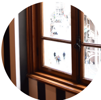
Esquadrias em madeira
