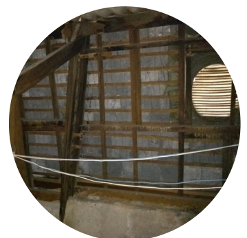
Estrutura do telhado em madeira
