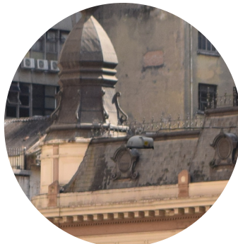
Telhado em ardósia
