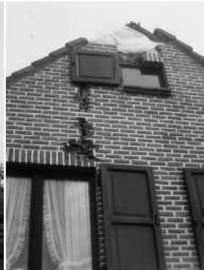
Figure 1 - Examples of roofs and facades damaged by lightning Exemplos de coberturas e fachadas danificadas por raios
