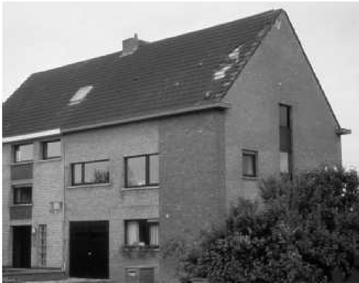
Figure 1 - Examples of roofs and facades damaged by lightning Exemplos de coberturas e fachadas danificadas por raios
