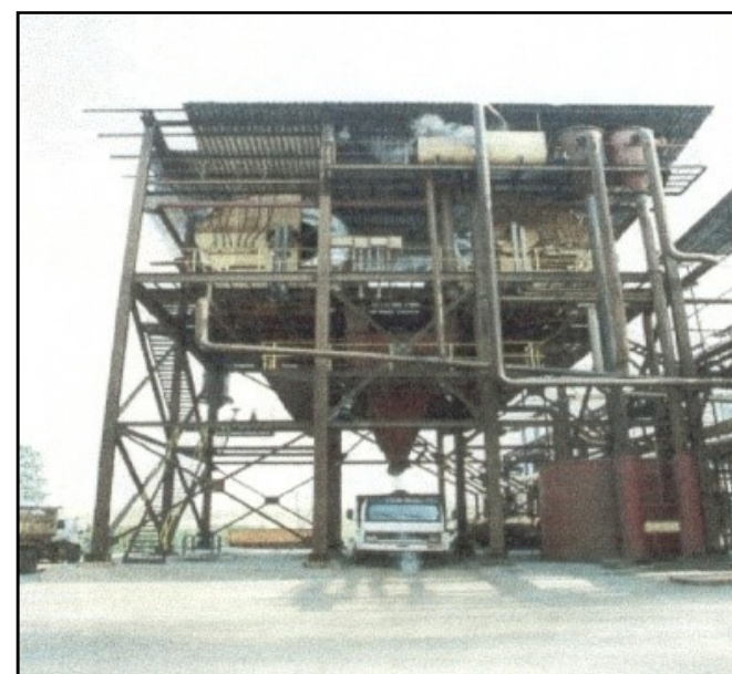
Descarregamento do lodo em filtro de 13" x 32"
