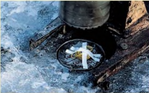
Foto C. Perforación de taladro
