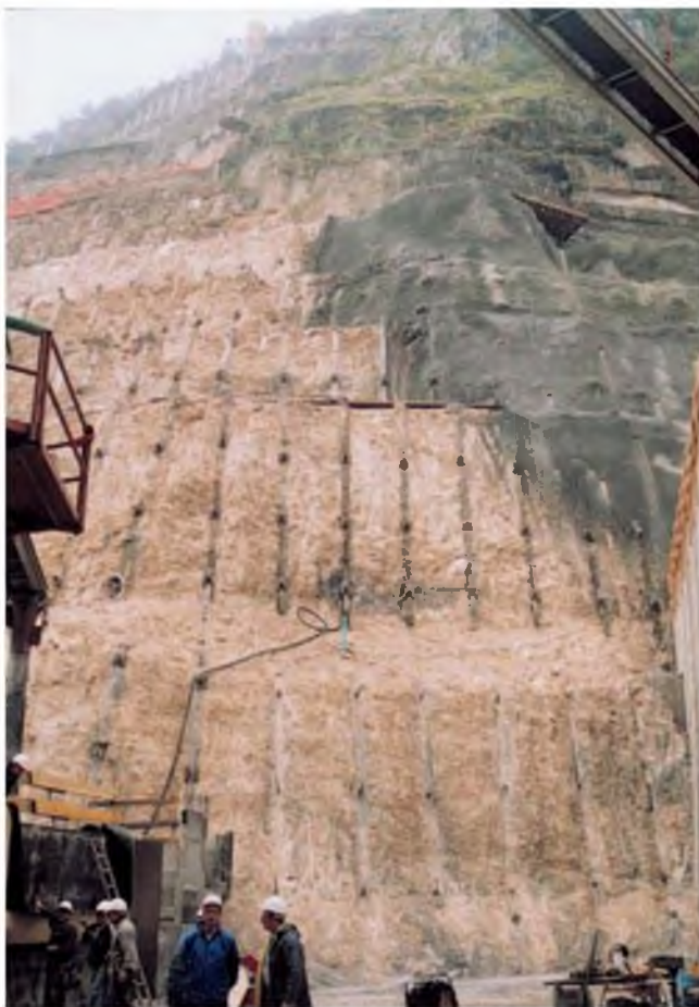
Figura 9.63 Excavación de un gran talud estabilizado mediante anclajes arriostrados, con la parte superior derecha protegida con gunita. Norte de Italia (foto M. Ferrer).
