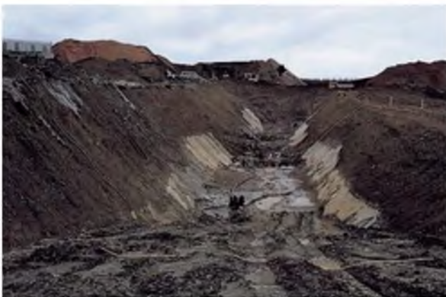
Figura 11.33 Excavación y tratamiento de la cimentación para apoyo del núcleo en una presa de materiales sueltos (foto L. González de Vallejo).
