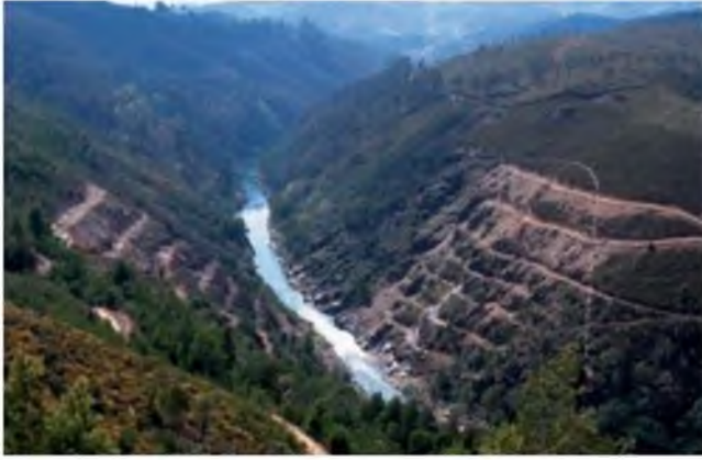
Figura 11.12 Grandes rozas excavadas para la investigación de una cerrada en laderas graníticas cubiertas de vegetación y suelos coluviales (foto R. Oliveira).
