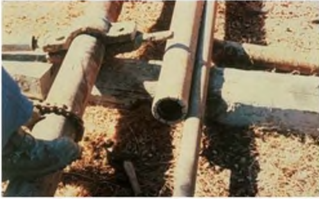
Figura 6.13 Baterías de perforación y coronas (foto L. González de Vallejo).
