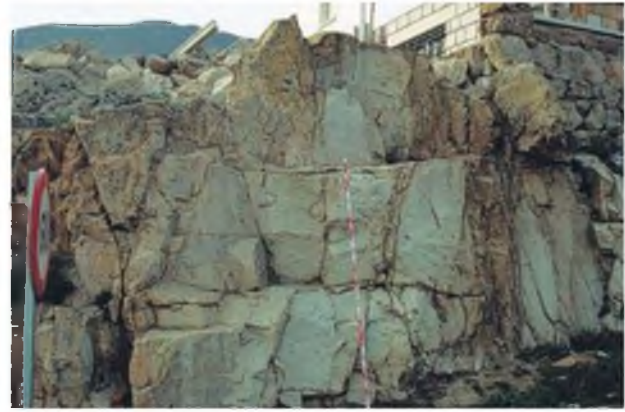
Granito. Calidad buena. Varias familias de discontinuidades alteradas.
