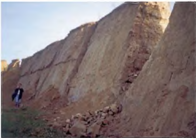
Figura 14.7 Frente de un deslizamiento traslacional de grandes bloques rocosos, NW de Italia (foto M. Ferrer).
