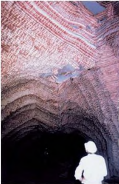
Figura 10.35 Grandes deformaciones en lutitas y sales: a) inicio de roturas en el techo; b) roturas generalizadas con grandes empujes en hastiales; c) cierre casi completo de la excavación con rotura de bulones (fotos L. González de Vallejo).
