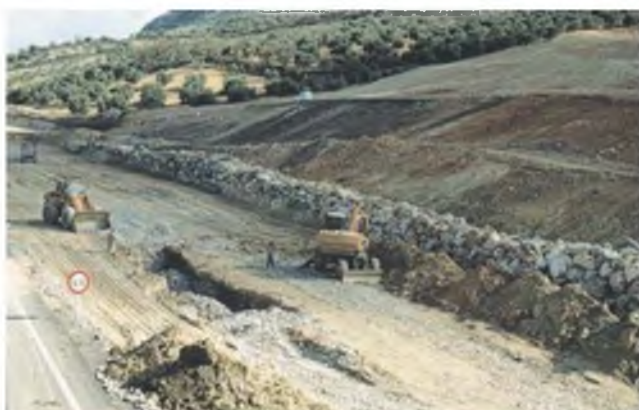
Figura 9.53 Medidas de estabilización en un talud de carretera de la Autovía A-92: colocación de una escollera para reforzar el pie del talud, escalonamiento y retallado del ángulo general y, en primer término, zanja rellena de grava para drenar la zona de pie (foto M. Ferrer).
