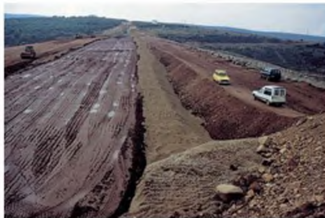
Figura 11.21 Materiales del núcleo, a la izquierda, y de drenes, en primer plano (foto L. González de Vallejo).
