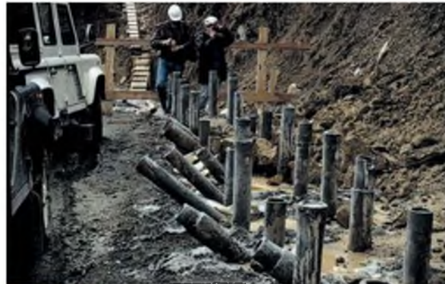
Figura 9.61 Refuerzo del pie de un talud con pantalla de micropilotes, norte de Italia (foto L. González de Vallejo).
