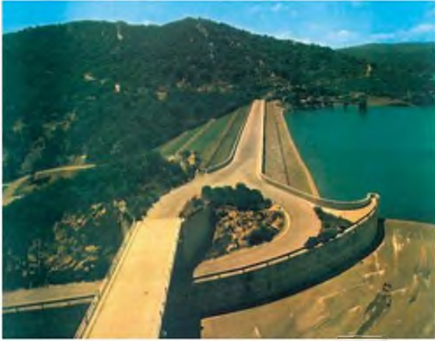
Figura 11.4 Presa de Guadarranque (Cádiz) sobre areniscas y margas del Eoceno; presa de tierras con núcleo de arcilla de 71 m de altura; en primer plano el aliviadero y al fondo la torre de toma (cortesía del CNEGP).
