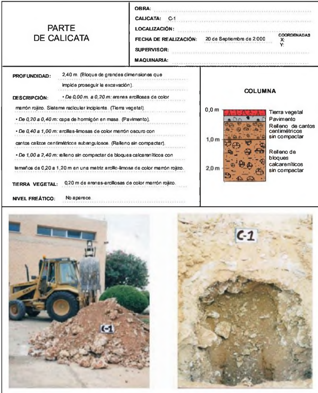
Figura 6.23 Registro de calicata (cortesía de Geoprim).
