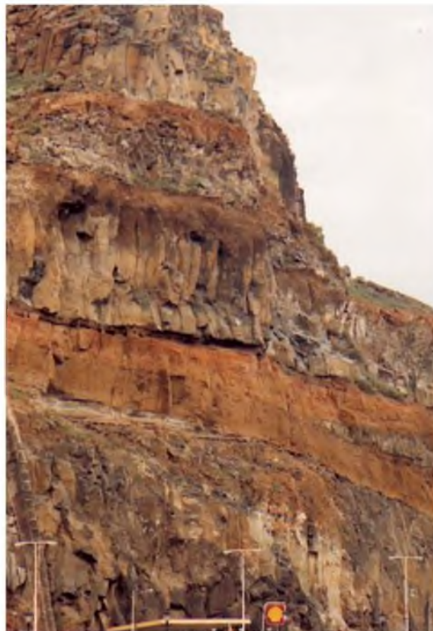
Figura 3.4 Alterancia de materiales rocosos con diferente composición y estructura en un talud de un macizo volcánico en La Gomera, que se manifiesta en distintos grados de alteración, resistencia y comportamiento mecánico (foto M. Ferrer).
