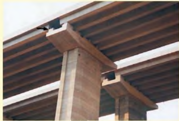
Figura F. Desplazamiento en los tableros de un viaducto de la autopista Estambul-Ankara (foto L. González de Vallejo).
