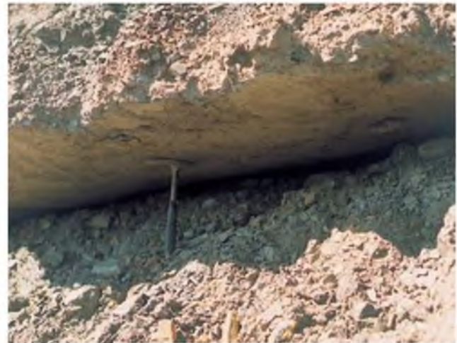
Figura 14.27 Superficie de rotura neta de un deslizamiento en materiales lutíticos, donde se observa el desplazamiento de la masa deslizada sobre la zona inferior estable, León (foto L. González de Vallejo).
