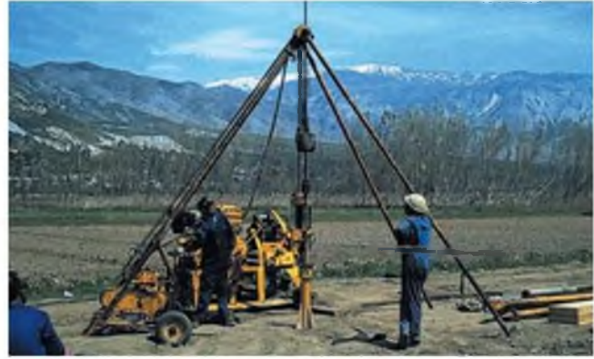
Figura 6.59 Equipo de SPT (foto L. González de Vallejo).
