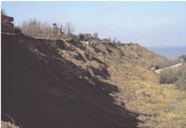
Figura 14.4 Vista de la parte superior de un deslizamiento rotacional en arcillas; obsérvese la grieta de tracción y la inclinación del terreno en sentido contrario a la ladera, con formación de charcos; Warden Point Cliff, Inglaterra (foto L. González de Vallejo).
