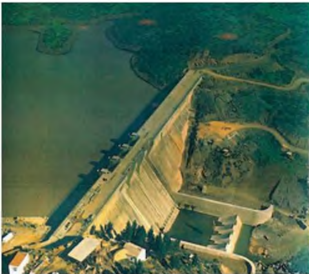
Figura 11.7 Presa de Sancho (Huelva), de gravedad, de 50 m de altura (cortesía del CNEGP).
