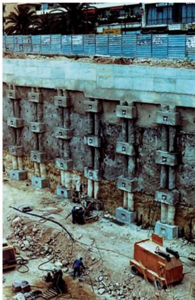
Figura 8.22 Pilotes formando una pantalla (cortesía de Uriel y Asociados, S.A.).
