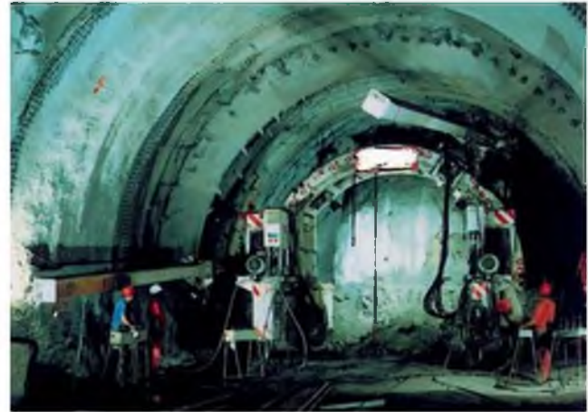
Figura 10.32 Excavación mediante precorte mecánico (cortesía de Rodio).
