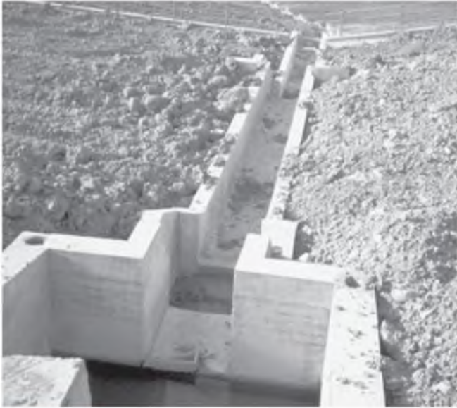
Figura 14.31 Sistema de zanjas de drenaje en «espina de pez» sobre una ladera inestable en el norte de Italia (foto M. Ferrer).
