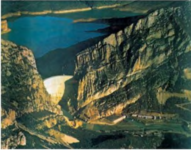
Figura 11.9 Presa de Canelles (Pirineo de Lérida) sobre calizas del Cretácico; presa bóveda de 151 m de altura (cortesía del CNEGP).
