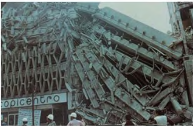
Fotografía A. Edificio destruido en el terremoto de México de 1985 (cortesía del IGME)
