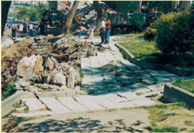
Figura E. Roturas producidas por licuefacción en un parque cerca del mar, Gölcük (foto L. González de Vallejo).
