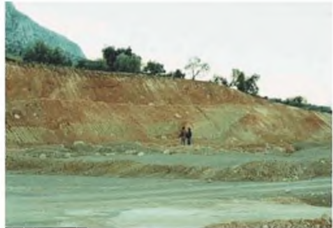
Figura 9.4 Excavación de un talud para construcción de una carretera (foto M. Ferrer).
