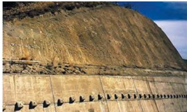
Estabilización de un talud con bulones y muro anclado
