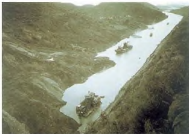
Figura 14.1 Los deslizamientos en las laderas del canal de Panamá retrasaron los trabajos durante años.
