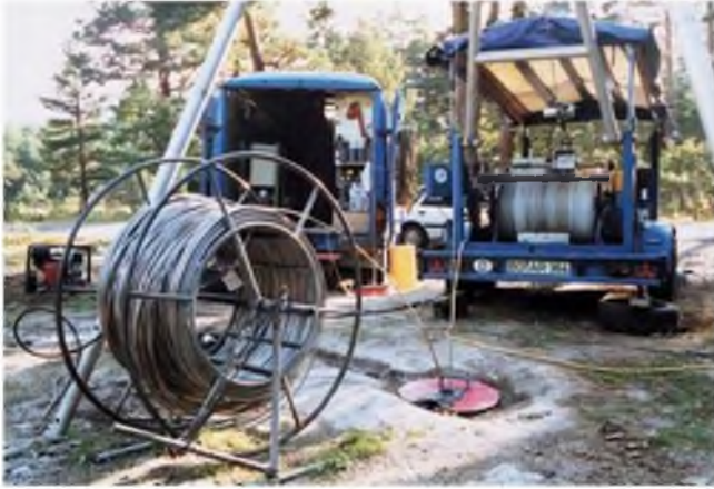
Figura 3.129 Equipo empleado en los ensayos de fracturación hidráulica (cortesía de In Situ Testing).
