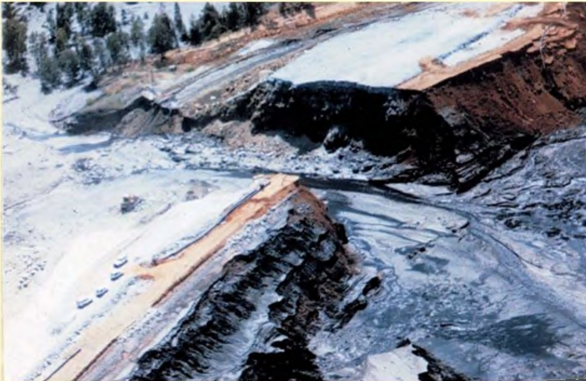
La presa de Aznalcóllar tras la rotura (cortesía de C. Olalla)
