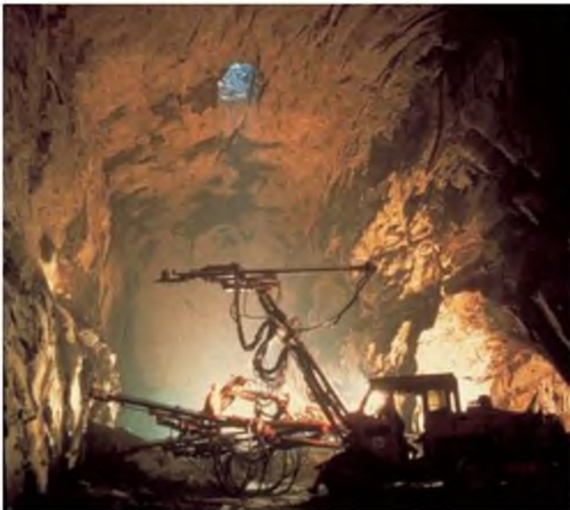
Figura 10.1 Excavación de una central hidroeléctrica subterránea (cortesía de J. Granero).
