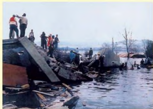
Figura D. El mismo edificio de la Figura C destruido por las réplicas sísmicas un mes más tarde (Yilmazer, 2000).
