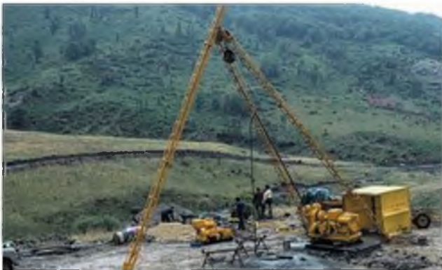
Sondeo geotécnico profundo
