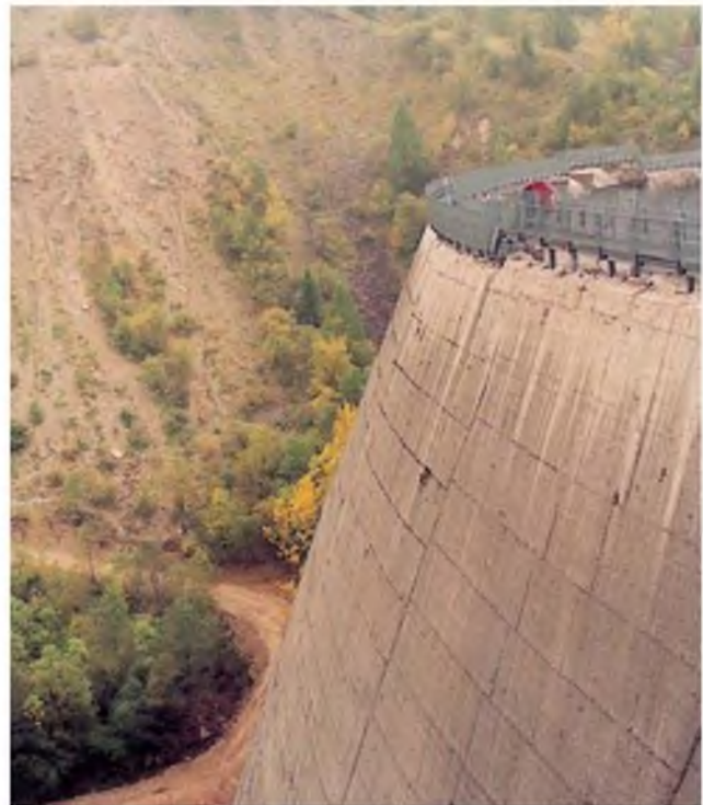
Figura 11.2 La presa de Vajont vista desde aguas arriba en la actualidad; obsérvese la masa deslizada ocupando el vaso. La presa no sufrió daños importantes (foto González de Vallejo).
