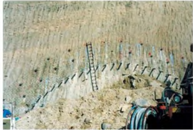
Figura 10.28 Refuerzo del talud frontal del emboquille de un túnel. Paraguas de micropilotes, bulones y malla; en fase posterior el talud sería cubierto con gunita (foto L. González de Vallejo).
