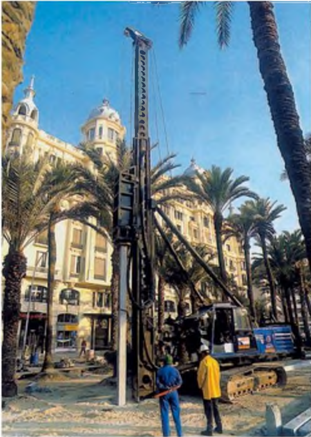
Figura 8.25 Hincia de pilotes prefabricados (cortesía de Grupo Terratest).
