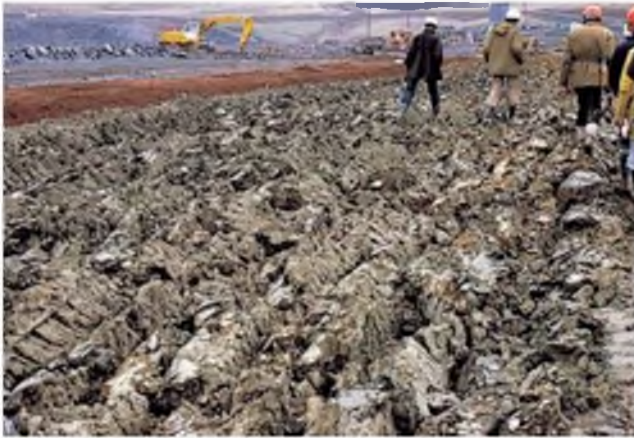
Figura 11.18 Aspecto de las arcillas compactadas para el núcleo de presas (foto L. González de Vallejo).
