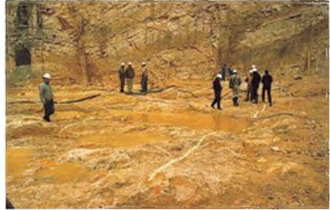
Figura 11.34 Preparación de la superficie de apoyo de la cimentación de una presa de hormigón (foto L. González de Vallejo).
