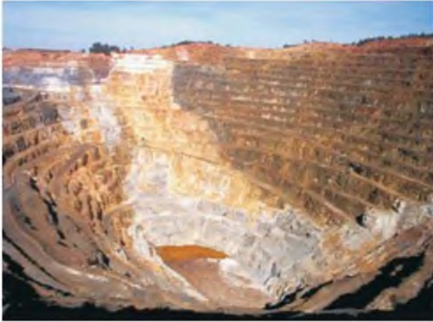
Figura 9.3 Taludes de la mina Corta Atalaya, Río Tinto, Huelva, con más de 300 m de profundidad (cortesía de P. Gumiel).
