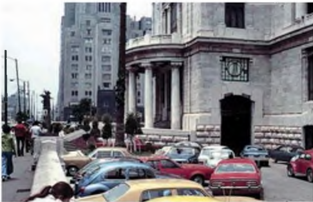
Fotografía C. Subsidencia del Palacio de Bellas Artes, México D.F. (foto L. G. de Vallejo)
