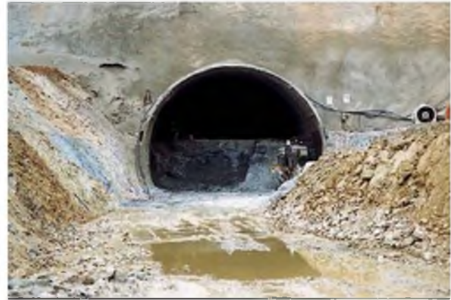
Figura 10.23 Excavación de la destroza (foto L. González de Vallejo).
