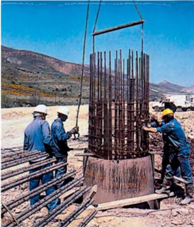
Figura 8.23 Colocación de armaduras en pilotes hormigonados in situ (cortesía de Grupo Terratest).
