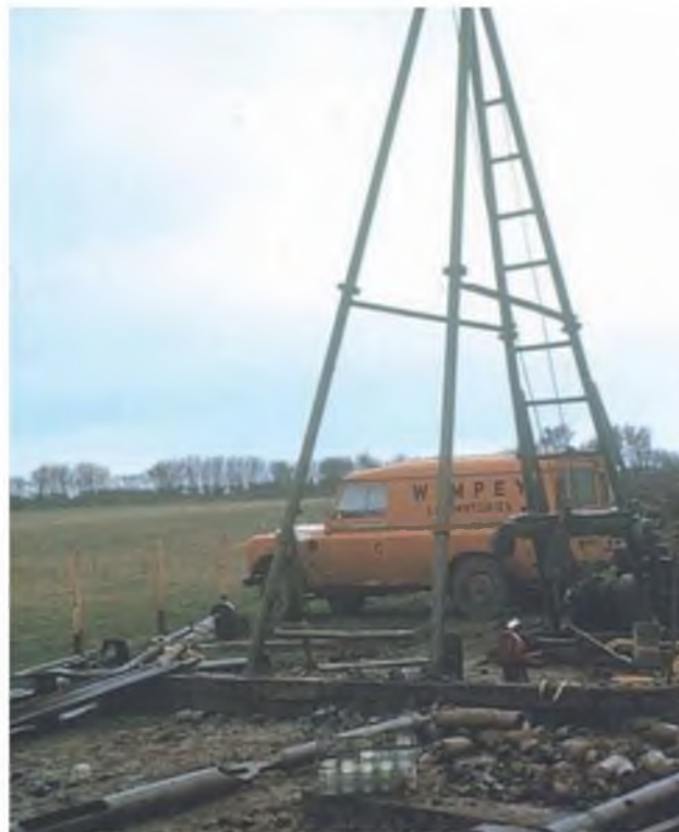
Figura 6.18 Sondeo a percusión, cuchara y trépano en primer plano (foto L. González de Vallejo).
