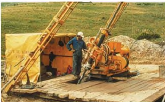
Figura 6.10 Sondeo a rotación, inclinado (foto L. González de Vallejo).
