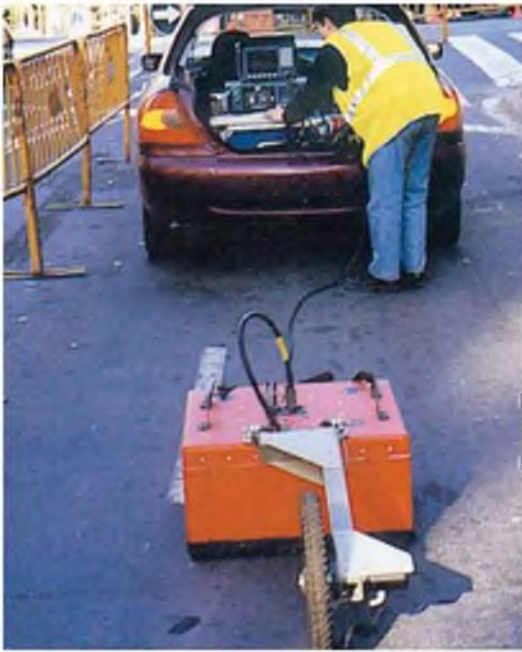
Figura 6.50 Equipo de geo-radar (cortesía de In Situ Testing S. A.).
