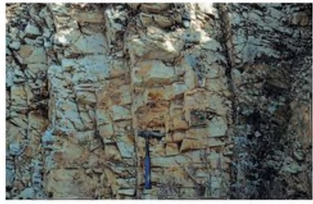
Cuarcitas ordovícicas. Calidad media. Grado de fracturación alto. Matriz rocosa muy resistente.
