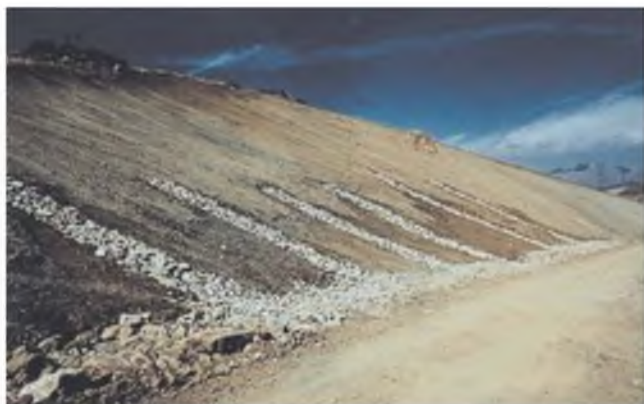
Figura 9.55 Drenes transversales al talud (foto L. González de Vallejo).
