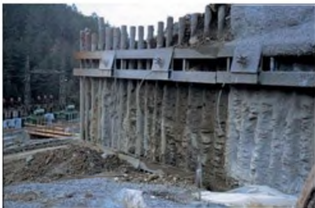
Figura 9.60 Pantalla anclada de micropilotes, norte de Italia (foto L. González de Vallejo).
