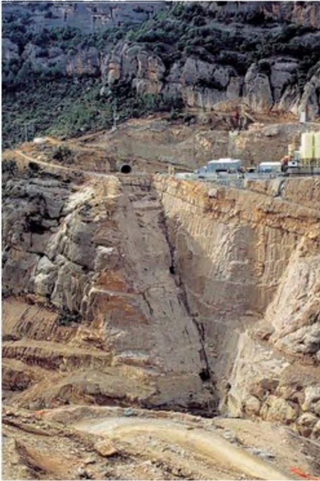
Figura 11.32 Excavación del estribo para una presa de bóveda (foto L. González de Vallejo).
