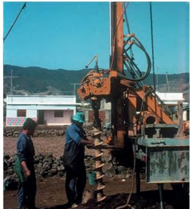
Figura 6.16 Sondeo helicoidal (foto L. González de Vallejo).
