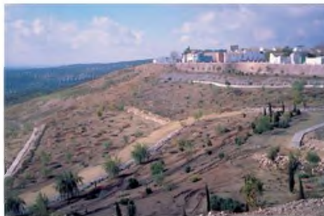
Figura 14.29 Vista de parte superior de la ladera de Benamejé tras las obras de estabilización (foto M. Ferrer).
