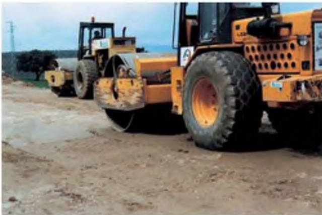
Figura 12.13 Compactación de la coronación de un terraplén con rodillo liso vibratorio.
