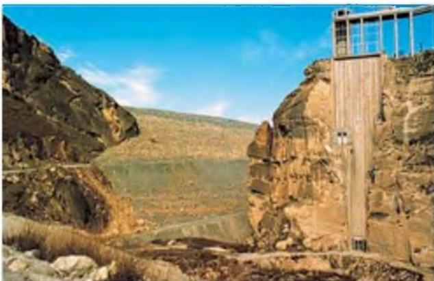
Figura 11.5 Presa de Canales (Granada) vista desde aguas arriba, sobre areniscas y margas limosas; presa de materiales sueltos de 156 m de altura, con espaldones de escollera y núcleo central de arcillas; obsérvese la torre de toma (foto L. González de Vallejo).
