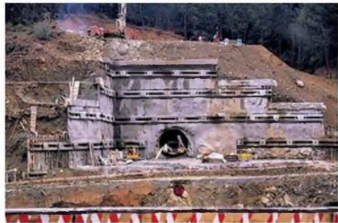
Figura 10.29 Emboquille de un túnel en rocas de mala calidad mediante pantalla anclada de micropilotes (foto L. González de Vallejo).
