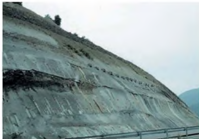
Figura 9.70 Talud de carretera cubierto de gunita (foto L. González de Vallejo).
