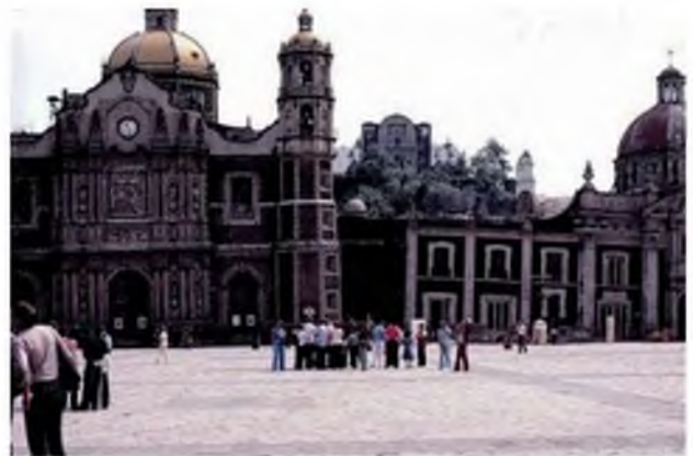
Fotografía D. Subsistencia en suelos lacustres afectando a la Basílica de N.ª S.ª de Guadalupe (México D.F.)
