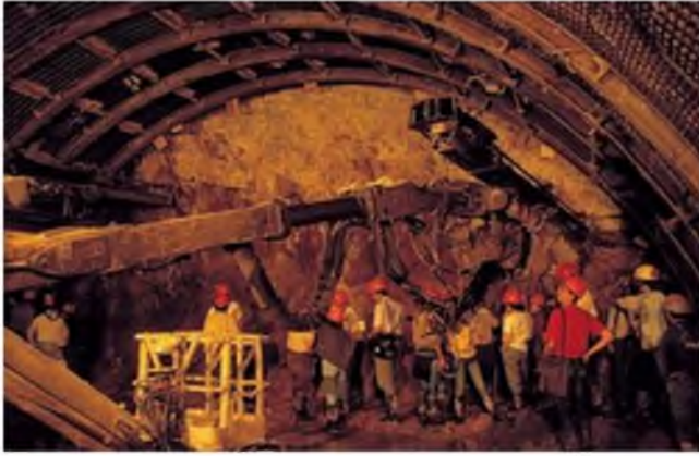
Figura 10.22 Excavación mediante martillo hidráulico y sostenimientos con cerchas y chapa Bernold (foto L. González de Vallejo).
