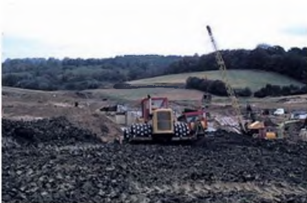
Figura 11.19 Compactación de los materiales de arcilla del núcleo con rodillos «pata de cabra» (foto L. González de Vallejo).
