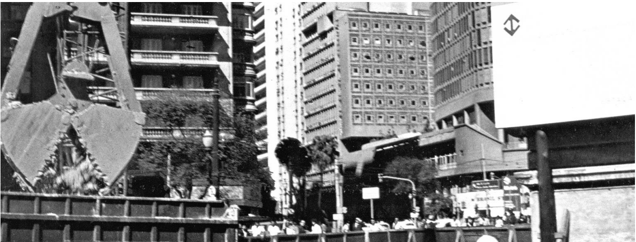
Figura 8.17 – Perfuratriz de estacas barrete - e de paredes diafragma (Metrô República. ANSON Engenharia de Fundações e Recuperações S.A).
