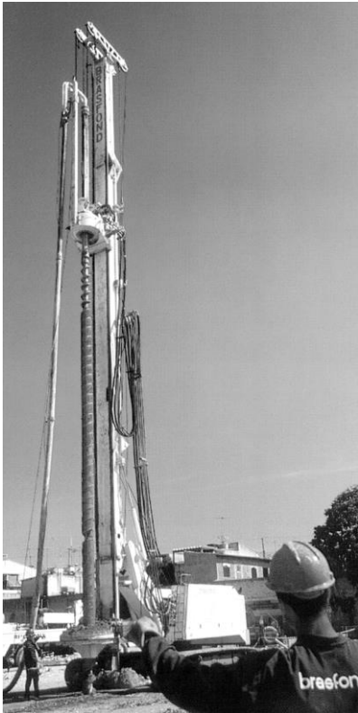
Figura 8.6 - Perfuratriz para estaca tipo hélice contínua -na foto, retirada de terra ( BRASFOND Fundações Especiais S.A.)
