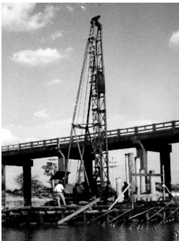
Figura 8.30 - Bate estaca tipo queda livre
