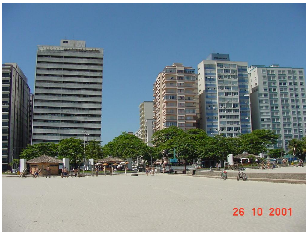
Figura 10.1 - Edifícios altos da orla de Santos
