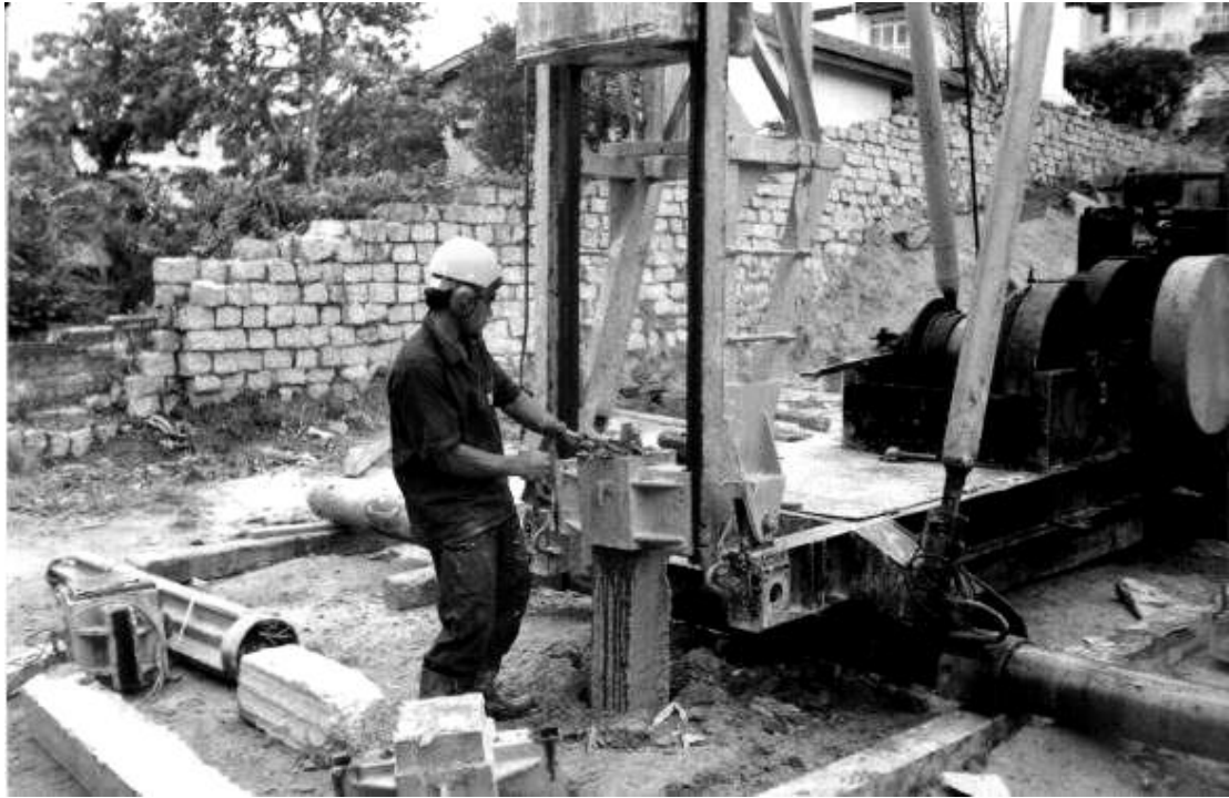
Figura 8.32 – Detalhe do bate estaca cravando uma estaca pré moldada
