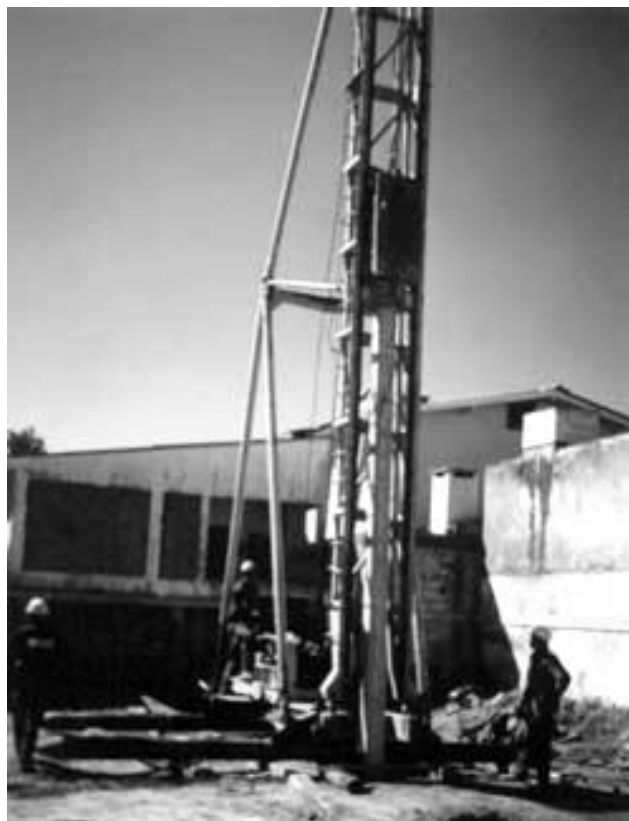
Figura 8.31 - Bate estaca cravando um estaca pré moldada
