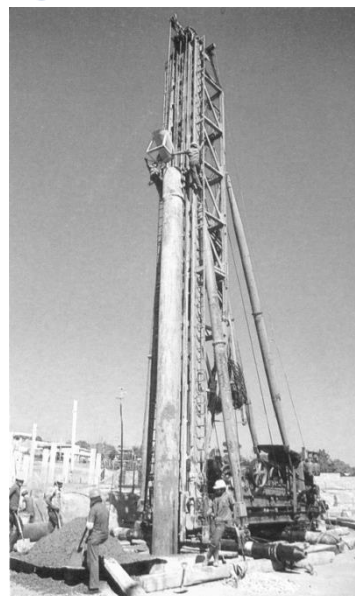
Figura 8.5 – Perfuratriz e camisa de proteção usadas em estacas Franki e Raiz (Geotécnica S.A.)
