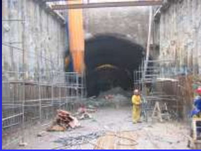
Estações, perfis metálicos atirantados e estroncas metálicas
