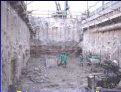
Estacas secantes e perfis metálicos atirantados
