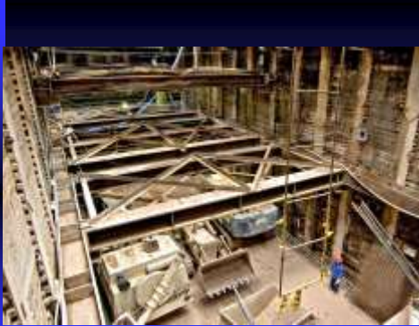
Perfis metálicos escorados e pranchada de madeira
