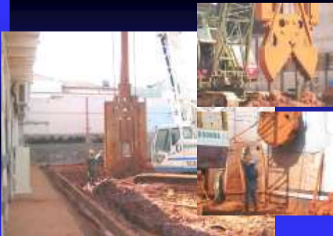
Escavação para parede diafragma
