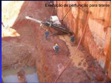
Parede diafragma atirantada
