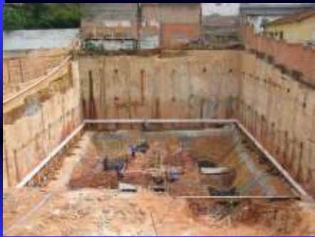
Parede diafragma atirantada
