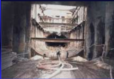
Estações, perfis metálicos atirantados e estroncas metálicas
