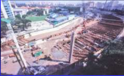
Parede diafragma escorada (perfis metálicos treliçados)
