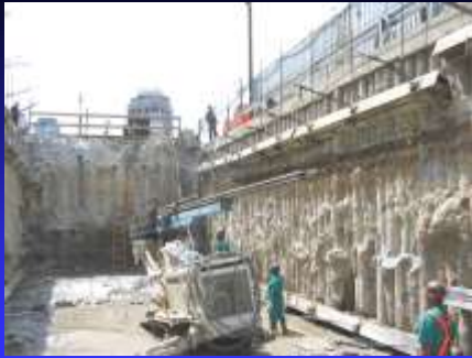
Estacas secantes e perfis metálicos atirantados
