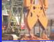
Estaca Barrete / Parede Diafragma
