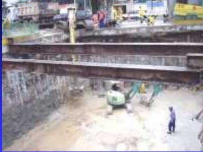
Estações, concreto projetado e estroncas metálicas
