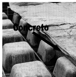
a) cobertura com lonas molhadas em trecho concretado da laje
