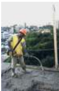
a) vibrador de imersão
