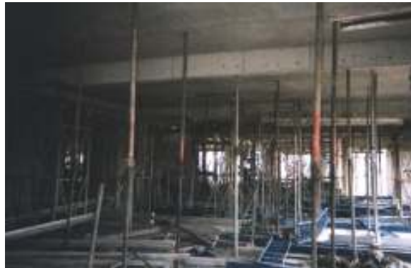
Re-escora de lajes e vigas
