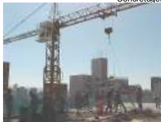
Grua segurando o mangote da bomba.
