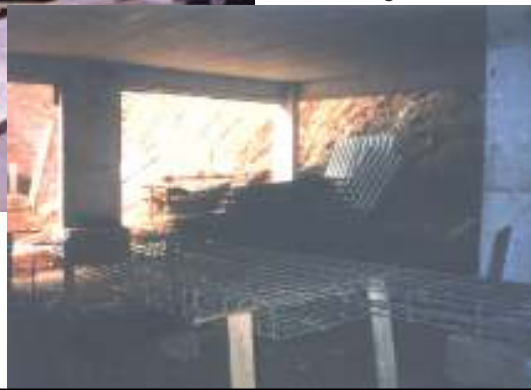
Pré-Montagem da armadura
