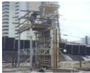
c) concretagem de pilar solteiro com caçamba da grua;
