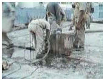
Concretagem de pilar.
