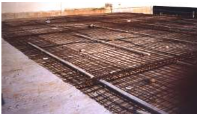
Laje pronta para concretagem (armada + caixas, marcações, conduites e indicação de nível)
