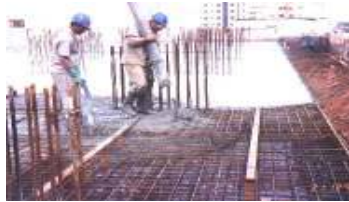
a) concretagem de laje com tubulação
