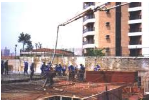
Lançamento com bomba
