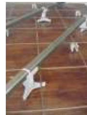
b) sarrafeamento do concreto
