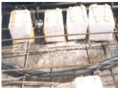
Blocos de isopor para passagens de prumadas isoladas na laje.
