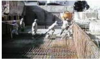
b) concretagem de laje com caçamba da grua
