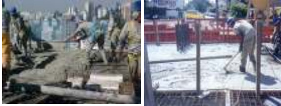
Espalhamento do concreto.
