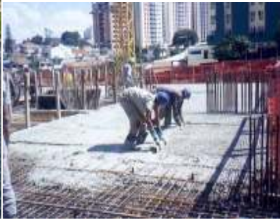
b) sarrafeamento do concreto
