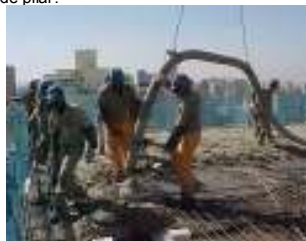
Grua segurando o mangote da bomba.
