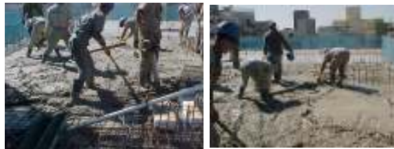
Concretagem da laje: a) espalhamento; b) sarrafeamento.
