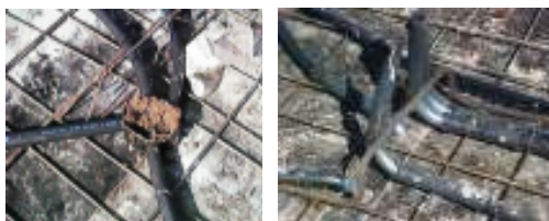
Instalações elétricas na laje: a) eletrodutos ligados à caixa de passagem; b) utilização de "caranguejo" para fixar os eletrodutos que saem para o lado superior da laje.
