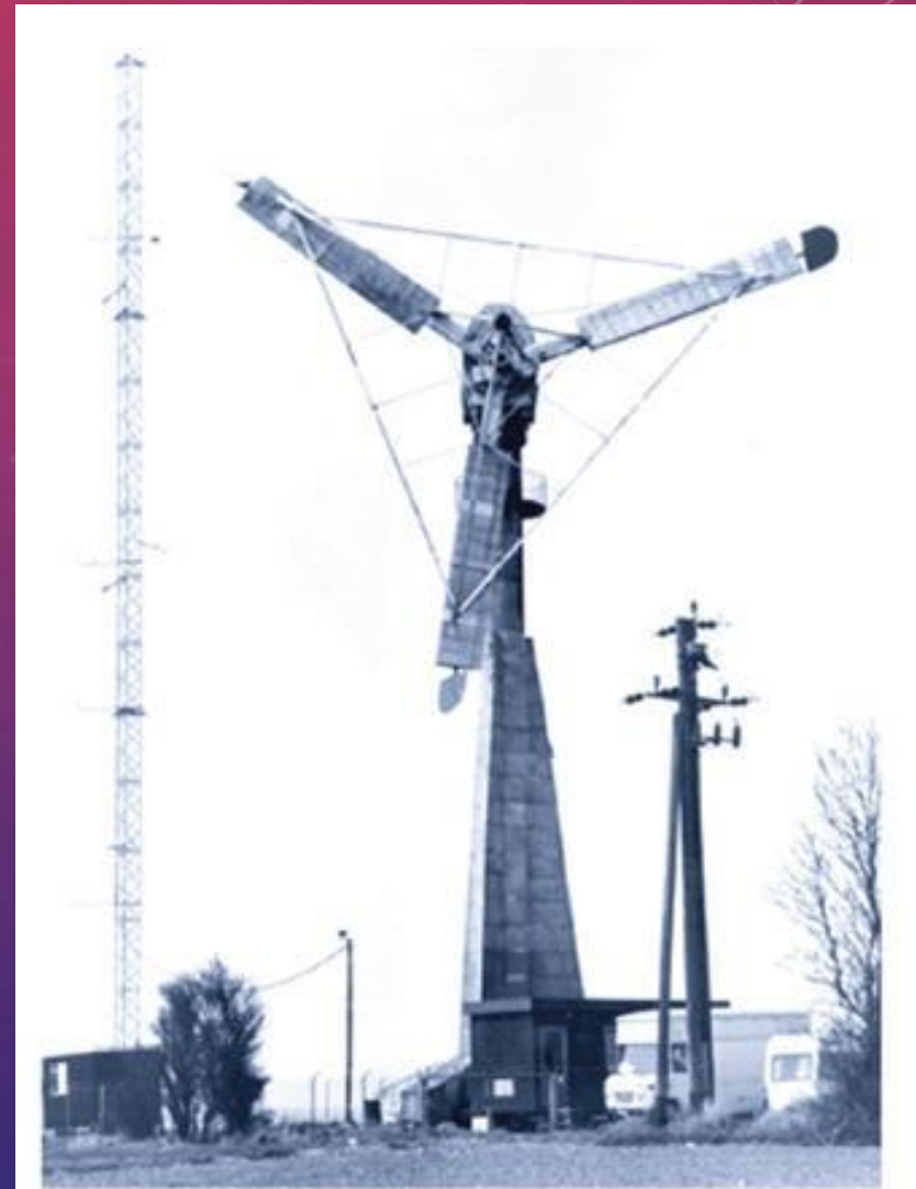
FIGURA 2.32 Turbina eólica de 200 kW instalada em Gedser, na Dinamarca. Fonte: The Danish Museum of Energy.
