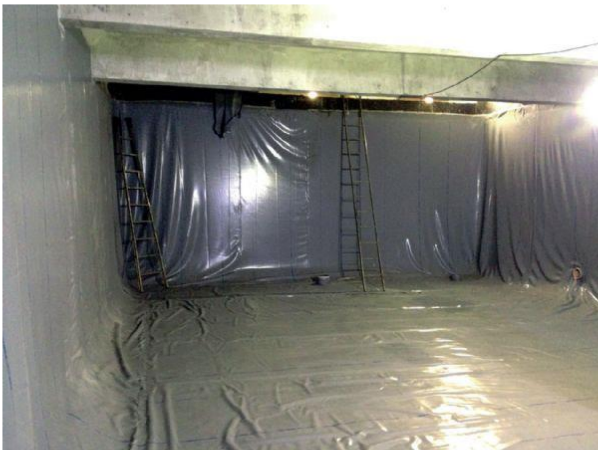
Aplicação de manta geossintética de PVC em reservatório
