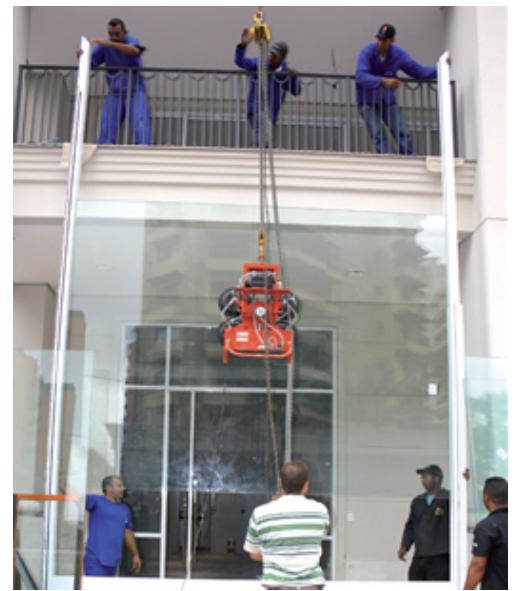
A logística de obra deve ser preparada para receber materiais de tamanhos variados
