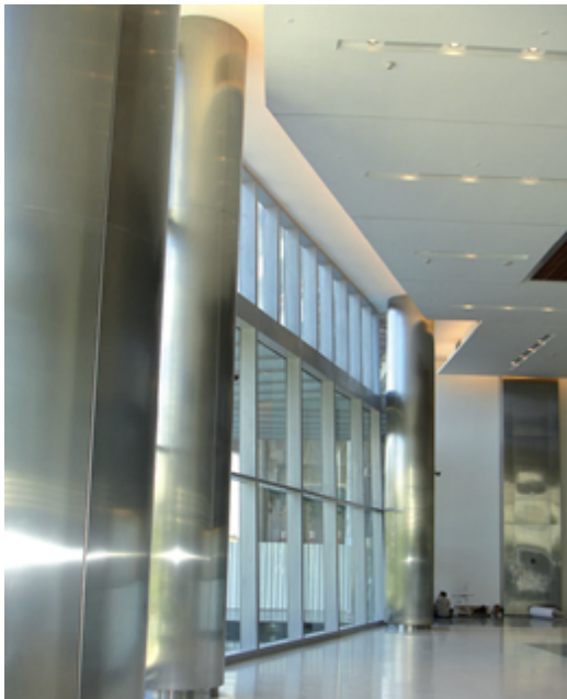
Quando o elemento é uma parede, deve-se obedecer às normas pertinentes a este elemento, como resistência a impactos, tempo de resistência ao fogo e outros
