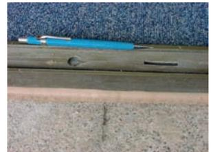
Saída dos drenos colmatados pelo cordão de silicone, ocasionando transbordamento de água pela canaleta junto à face interna do caixilho (piso elevado revestido de carpete)
