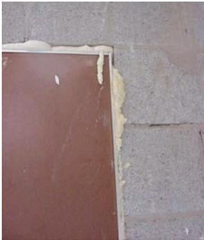
**Junta preenchida com espuma expansiva de poliuretano**
