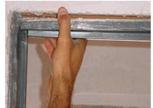
Assentamento de janela com argamassa não se obedecendo a junta mínima para distribuição uniforme da argamassa – fazendo os blocos cerâmicos
