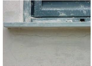
Assentamento de peitoril de janela com argamassa – destacamento em função da retração da argamassa
