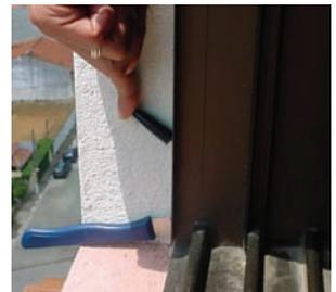
Falha ou ausência de cordão de selante de cura neutra à base de silicone ocasionam deficiência na estanqueidade do sistema
