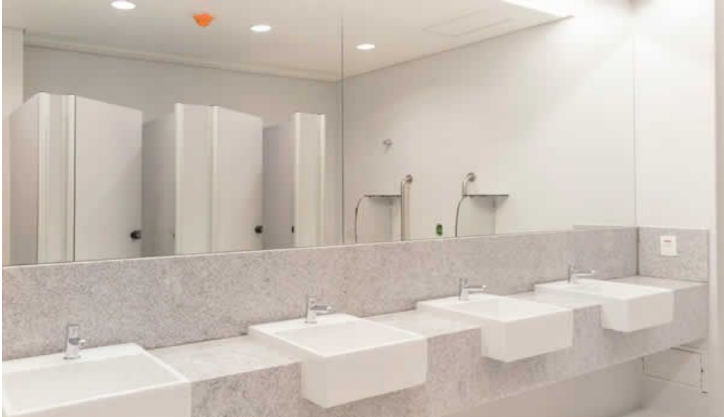
Figura 1 - Banheiros chegam ao canteiro com revestimentos e acabamentos
