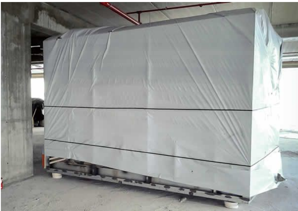
Figura 6 - Projeto deve prever vãos com dimensões suficientes para que os módulos sejam entregues nas lajes
