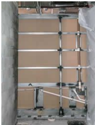
Figura 2 - Detalhe das instalações executadas em fábrica
