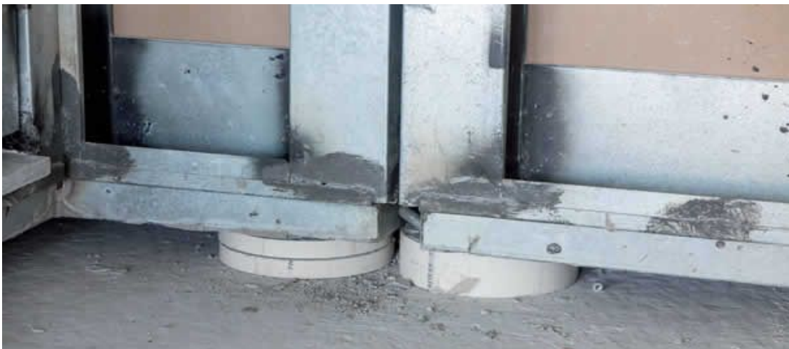
Figura 7 - Detalhe do nivelamento do banheiro em obra
