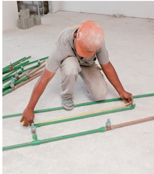
Quando o material chega à obra, podem ser feitas aferições simples, como inspeção visual e medição
