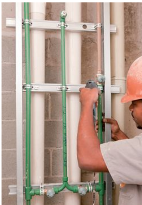
Kits prontos para sistemas hidráulicos reduzem mão de obra e praticamente eliminam perda de material
