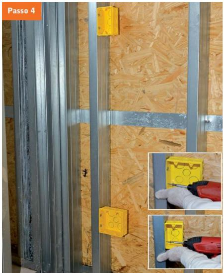
4. Faça a fixação da caixa no perfil metálico, usando dois parafusos. Repita o processo nas caixas 4 x 2.
