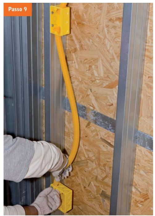
9. Continue o procedimento, engatando o conduíte na caixa inferior e recortando o excesso. Nunca disponha as tubulações verticais por trás dos montantes sob risco de serem perfuradas por parafusos na etapa de fechamento com drywall.
