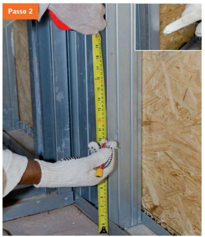
2. Em seguida, marque a localização das caixas de energia 4 x 4. Elas deverão ser fixadas a 30 cm do piso, conforme indica o projeto.
