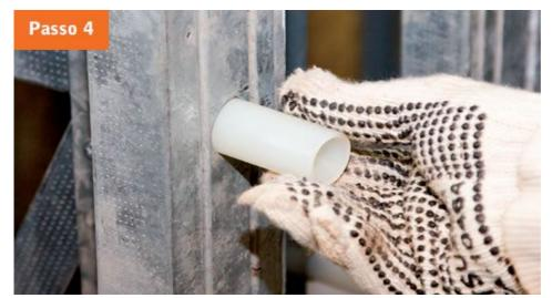
4. Posicione um pedaço de tubo de PVC no furo, evitando o contato direto entre o perfil e o tubo PEX e, consequentemente, evitando cortes e danos na tubulação.
