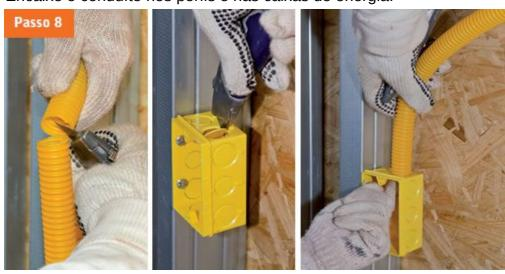
8. Com o estilete, corte os conduítes e faça as aberturas das caixas de energia. Transpasse o condutor por elas.
