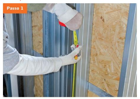
1. Com a trena, meça e marque a altura do local de fixação das caixas de energia 4 x 2, que neste caso serão instaladas a 1,10 m de altura do piso.
