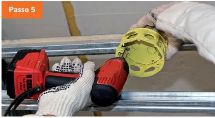
5. Parafuse a caixa octogonal de passagem no perfil metálico do teto.
