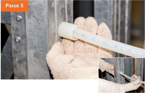
**5.** Transpasse a tubulação de PEX no perfil, através do protetor. Nunca disponha as tubulações verticais por trás dos montantes sob risco de serem perfuradas por parafusos na etapa de fechamento com drywall.
