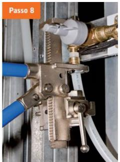
7. Conecte as tubulações de água quente 8. Com o alicate prensa, finalize o e fria nas respectivas saídas dos registros. serviço prensando o anel de latão Conforme indicações do projeto, repita a mesma operação nas saídas e entradas de água da bacia sanitária.
