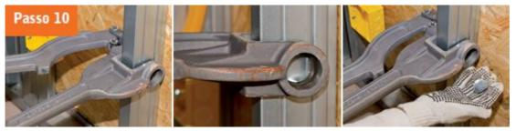
**10.** Com o furador de perfil, fure os pontos por onde passarão os conduítes nos perfis metálicos. Alguns perfis já vêm furados de fábrica. Se for esse o caso, basta pular para a próxima etapa.
