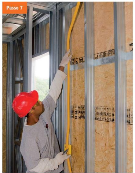
7. Encaixe o conduíte nos perfis e nas caixas de energia.
