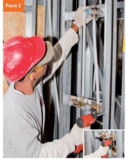
2. Encaixe o kit chuveiro nos perfis metálicos e fixe-os com parafusos galvanizados.
