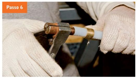
**6.** Para facilitar a conexão nos registros, alargue os tubos de PEX com auxílio de alicate próprio para essa tarefa.
