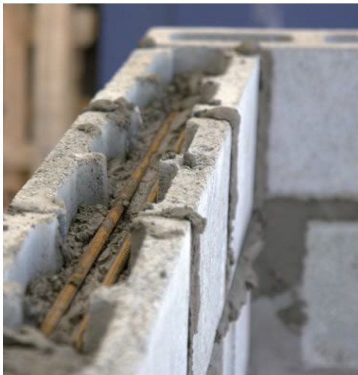
O uso dos vergalhões - em comprimento 20% maior do que o vão de cada lado - proporciona a solidarização da estrutura de distribuição de cargas à alvenaria
