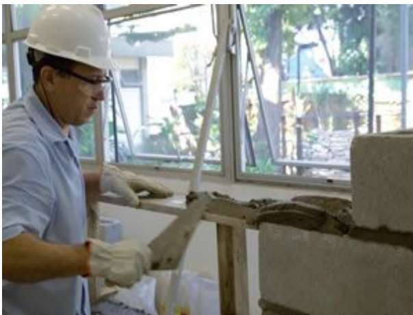
Após a execução da contraverga, é preciso criar uma estrutura para escoramento da sustentação da verga enquanto ela não ganha a resistência necessária
