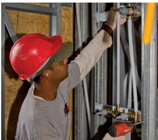
A fixação do kit chuveiro é feita com parafusos galvanizados. Na foto, instalação de kit em estrutura de steel frame
