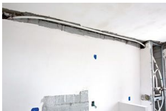
Como o PEX é flexível, o caminhamento da tubulação é mais simples. Mas é importante evitar curvaturas acentuadas. Tubos dobrados em ângulo muito fechado restringem o fluxo de água e diminuem a pressão no ponto de utilização
