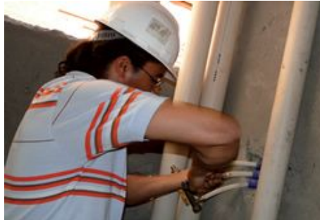
Figura 4 - Instalação de um chicote realizada na obra para a validação do projeto
