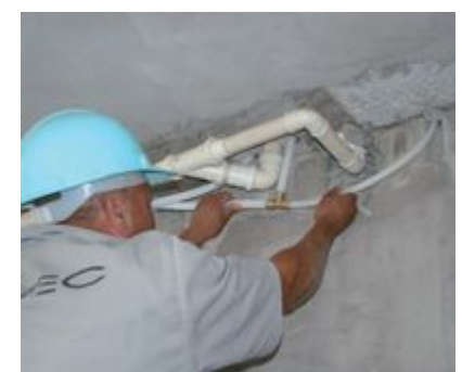
Figura 11 - Chicote sendo instalado visto do andar inferior
