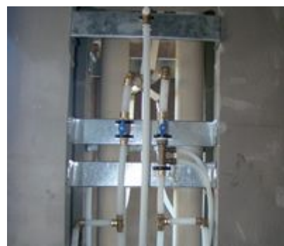
Figura 14 - Detalhe do chassi de chuveiro
