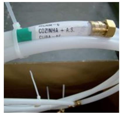
Figura 7 - Chicote com o código de identificação do local a ser instalado
