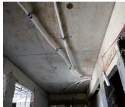
Figura 12 - Caminho da tubulação na laje inferior
