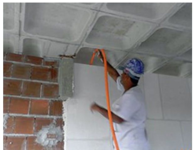
Figura 17 - Vista da colocação dos eletrodutos nos alvéolos assentados na vertical
