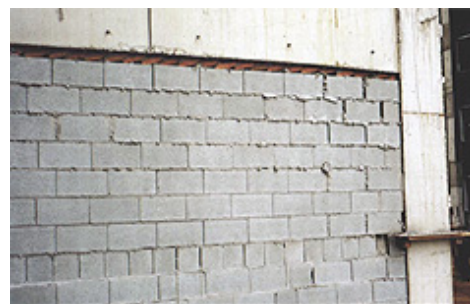
A fixação com encunhamento tradicional (foto) está sendo substituída pela ligação alvenaria-estrutura com argamassa
