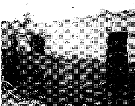
Figura 1 – Construção temporária com um pavimento.
