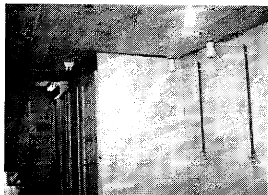
Figura 8 – Acabamento interno com película de fibra de vidro
