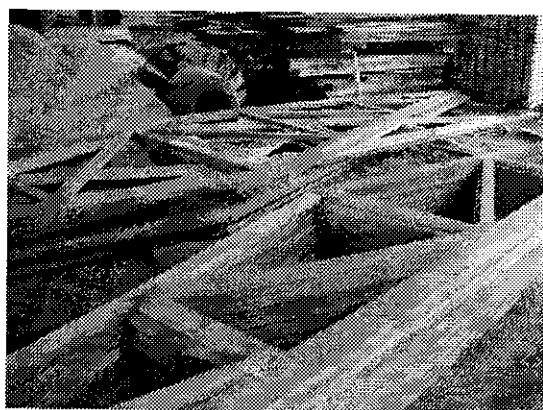
Figura 1.5 – Tesoura montada com conectores
