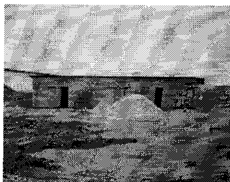
Figura 16 – Construção temporária executada em alvenaria
