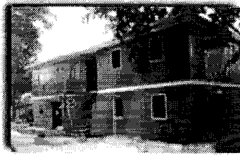
Figura 14 – Construções temporárias de fibra de vidro
