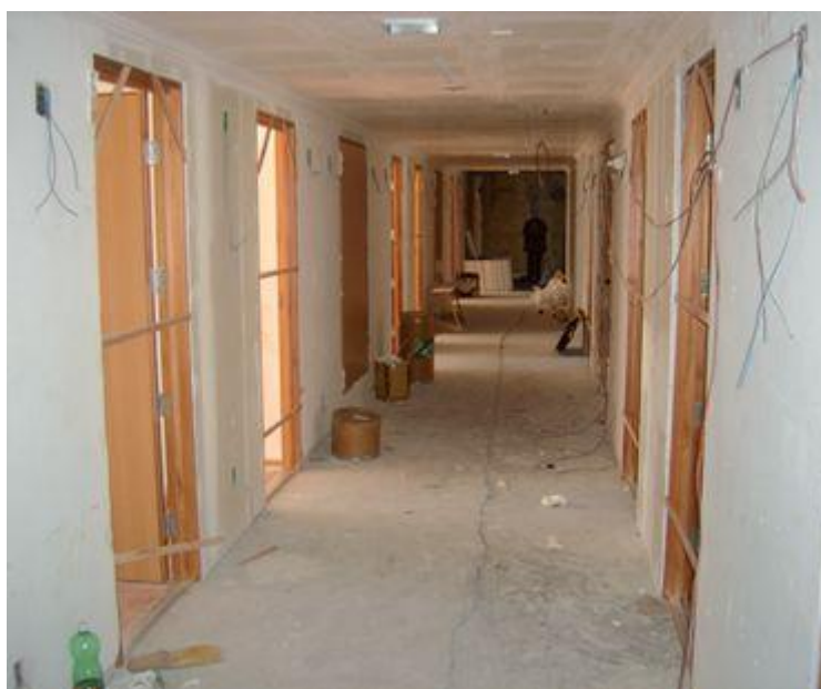
Kits porta pronta devem ser instalados de acordo com o sentido de abertura e respeitando o espaço de 5 mm entre a soleira ou o piso acabado e a porta
