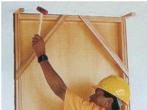
Fixação com cunhas de madeira
