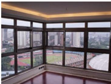
Com vidros acústicos instalados com vedações especiais, a esquadria de alumínio da Atenuasom foi ensaiada pelo IPT. A composição é de duas camadas de vidro de 4 mm, intercaladas por uma câmara de ar de 20 mm
