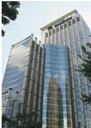
A fachada do Bank Boston conta com 22 mil m<sup>2</sup> de vidros duplos de baixa emissividade
