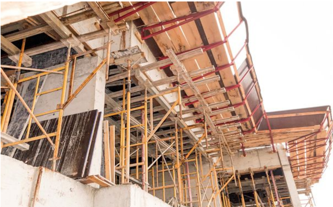
A etapa de concretagem requer a definição prévia dos equipamentos de proteção individuais e coletivos, como bandejas e guarda-corpos
