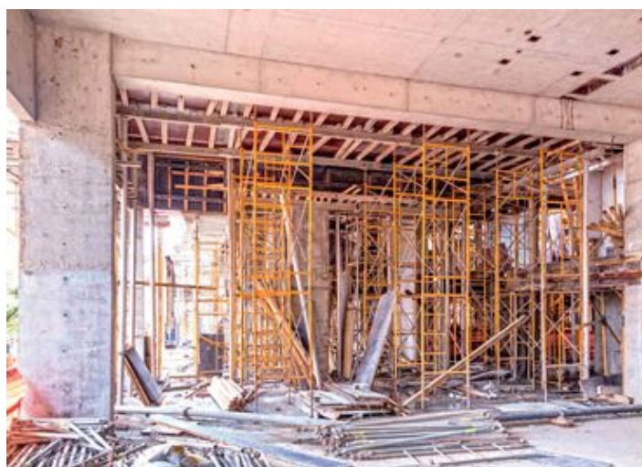
O contraventamento é necessário em pavimentos com pé-direito superior a 4 m para que a estrutura não entre em colapso. Tubos e braçadeiras das torres cumprem este papel no edifício Trend Tower, em Barueri (SP)
