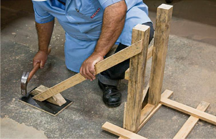
**17** Em seguida, fixe a base do aprumador na laje, utilizando pregos de aço.
