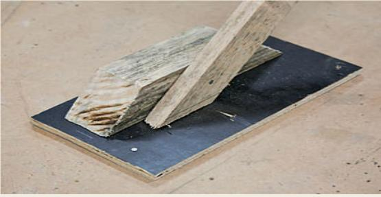
Os aprumadores são peças compostas por uma base fixada na laje (feita de chapa compensada e um pedaço de caibro cortado em formato trapezoidal), e por um sarrafo inclinado que dá sustentação à fôrma do pilar.
