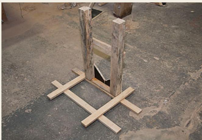
**14** A estrutura se encaixa perfeitamente no gualho, um "gabarito" fixado no local exato onde o pilar será concretado.
