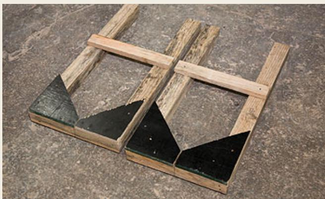
**13** A estrutura dos painéis (grade) é composta por caibros verticais contraventados por sarrafos horizontais. Duas peças triangulares (chapuzes) feitas a partir da chapa de compensado reforçam a base, dando estabilidade ao conjunto.
