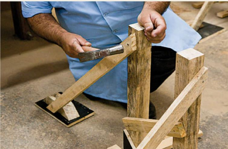
**19** Repita o processo no outro caibro. Note que o aprumador é fixado perpendicularmente à peça anterior.
