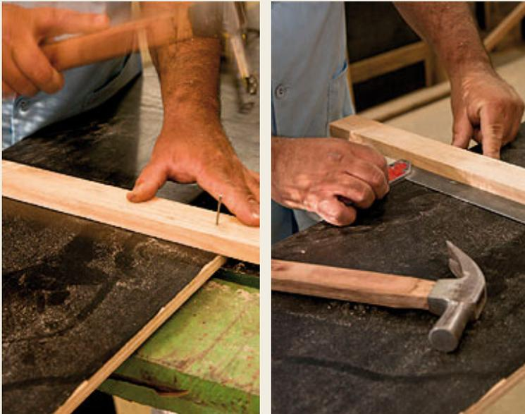
**10** Pregue um sarrafo na chapa, que servirá de guia na direção perpendicular. Use o esquadro para se certificar de que o sarrafo será fixado a exatamente  $90^\circ$  da borda da chapa.
