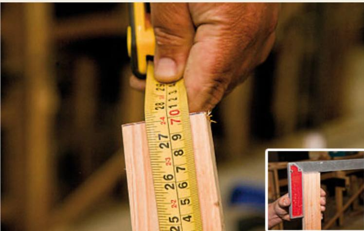
**5** Certifique-se de que a peça foi cortada nas dimensões precisas determinadas no projeto e, com o esquadro, verifique se o corte foi feito a 90°.
