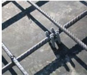
O distanciador tipo cadeirinha é indicado para uso em armaduras horizontais, com lajes, fundo de vigas e pré-moldados. Esse tipo de acessório deve ser quantificado de acordo com as dimensões e peso das armaduras, e deve ser posicionado de modo intercalado sob as armaduras.
