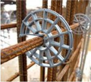
O distanciador plástico circular pode ser utilizado em laterais de vigas, paredes de concreto e pré-moldados. A quantidade varia de quatro a cinco peças por metro quadrado, aplicadas de maneira intercalada nos estribos.
