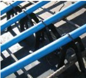
Indicado para apoiar cordoalhas de protensão e armaduras negativas, este espaçador deve ser fixado na fôrma com pregos ou grampos de pressão.
