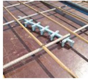
O distanciador tipo centopeia é indicado para armaduras horizontais, como lajes, fundo de vigas, sapatas e pré-moldados. Resistente a elevadas cargas, cada peça deve apoiar pelo menos dois pontos das armaduras.
