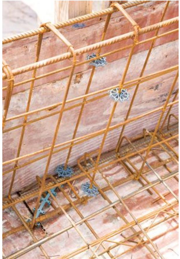
Para evitar esse tipo de situação tão perigosa, a norma técnica brasileira NBR 6118:2007 "Projeto de Estruturas de Concreto - Procedimento" estabelece requisitos de qualidade para o concreto empregado nas estruturas, bem como o cobrimento mínimo das armaduras em função da agressividade do ambiente onde ela foi construída.
